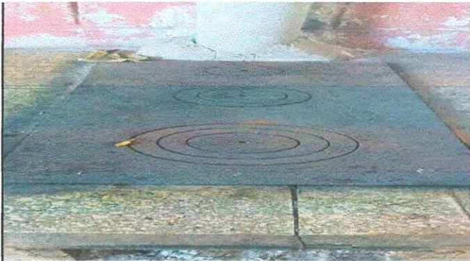
SUSTITUCION DE PLANCHA
