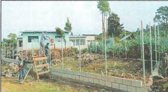
SUSTITUCIÓN DE MUROS PERIMETRALES
