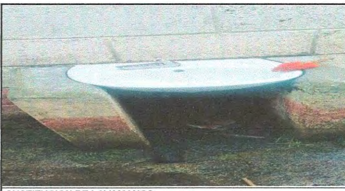
SUSTITUCION DE LAVAMANOS
