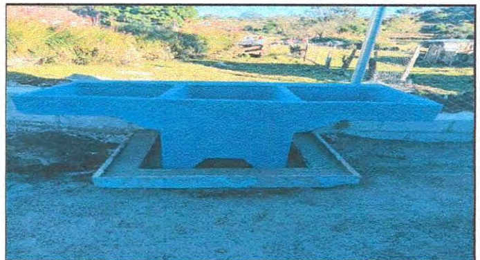
SUSTITUCION DE PILA DE CEMENTO
