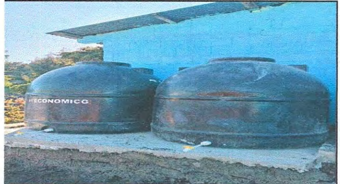
SUSTITUCIÓN DE DEPOSITO DE AGUA
