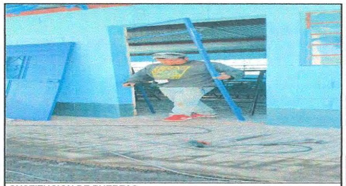
SUSTITUCION DE PUERTAS
