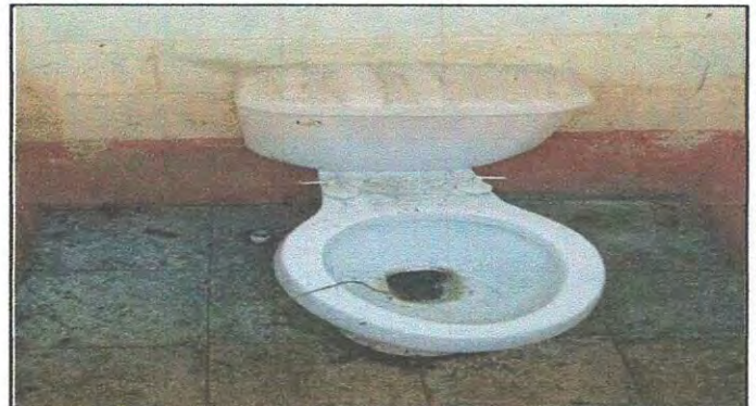
SUSTITUCION DE INODOROS
