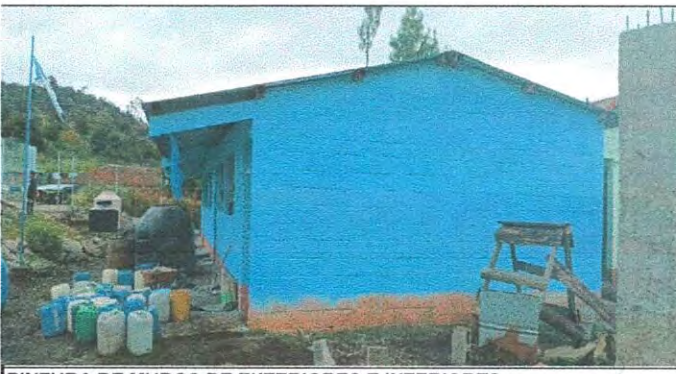
PINTURA DE MUROS DE EXTERIORES E INTERIORES
