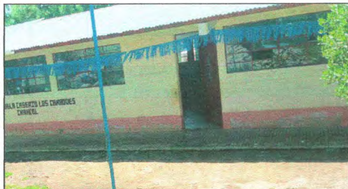
REPARACION DE PLANCHAS DE CONCRETO DE PATIO
