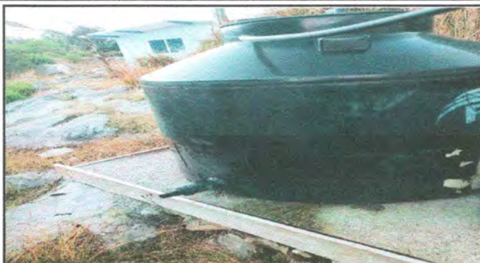
SUSTITUCIÓN DE DEPOSITO DE AGUA
