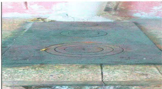
SUSTITUCION DE PLANCHA
