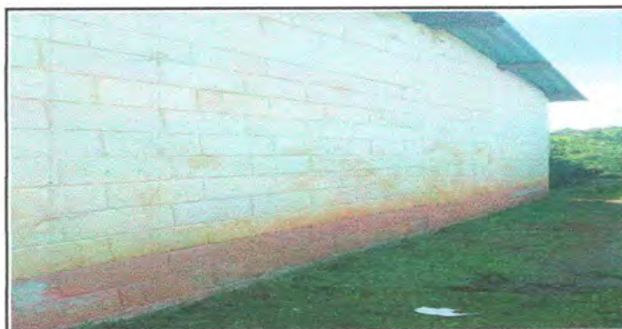
PINTURA DE MUROS DE EXTERIORES E INTERIORES
