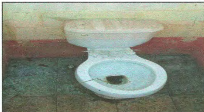
SUSTITUCION DE INODOROS
