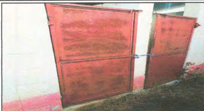
SUSTITUCIÓN DE PUERTA EN SERVICIO SANITARIO
