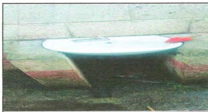
SUSTITUCION DE LAVAMANOS
