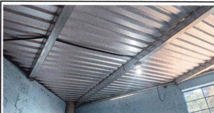
FOTO 16: REPARACION DEL SISTEMA ELECTRICO
