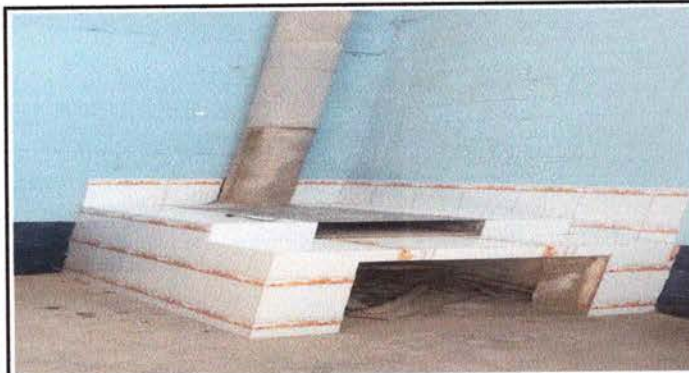
FOTO 9: REPARACION DE COCINA
