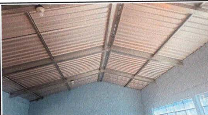
FOTO 3: SUSTITUCIÓN DE ESTRUCTURA DE MADERA POR METAL
