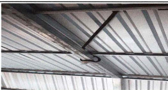
FOTO 17: REPARACION DEL SISTEMA ELECTRICO
