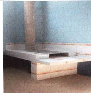
FOTO 10: REPARACION DE COCINA
