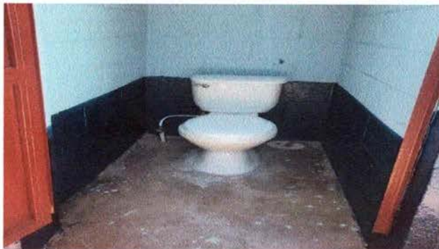
FOTO 13: SUSTITUCION DE INODORO
