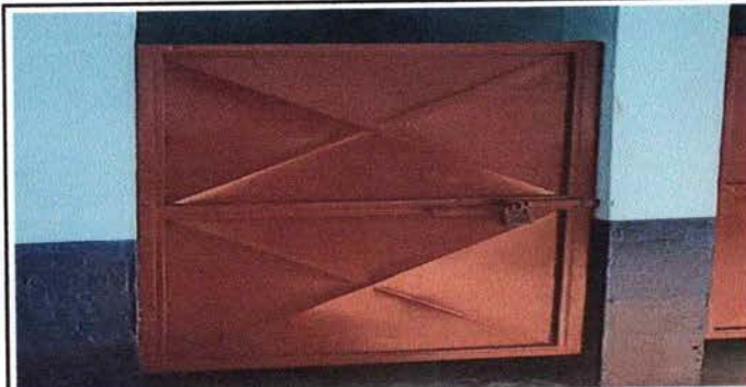
FOTO 5: MANTENIMIENTO DE PUERTAS, INCLUYE PINTURA
