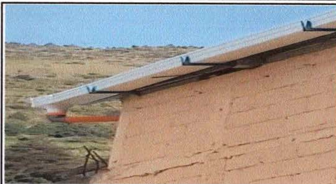
FOTO 14: CANALES Y BAJADAS DE AGUA PLUVIAL
