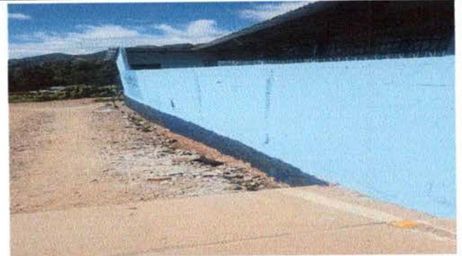
FOTO 8: PINTURA EN MUROS EXTERIORES E INTERIORES
