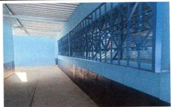
FOTO 4: MEJORAMIENTO DE BALCONES
