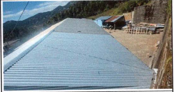
FOTO 2: SUSTITUCIÓN DE CAPOTE TROQUELADO Y LAMINA
