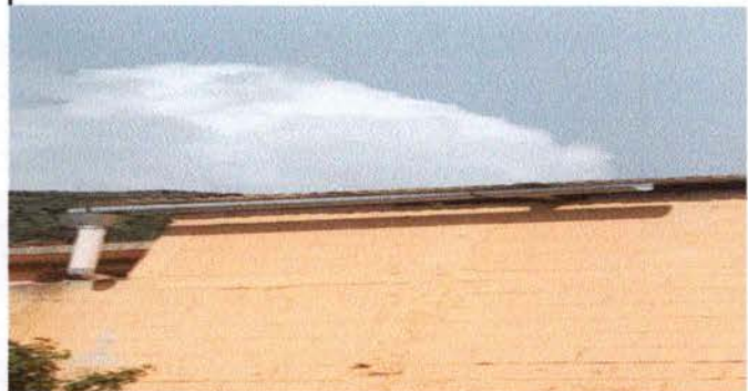
FOTO 14: CANALES Y BAJADAS DE AGUA PLUVIAL
