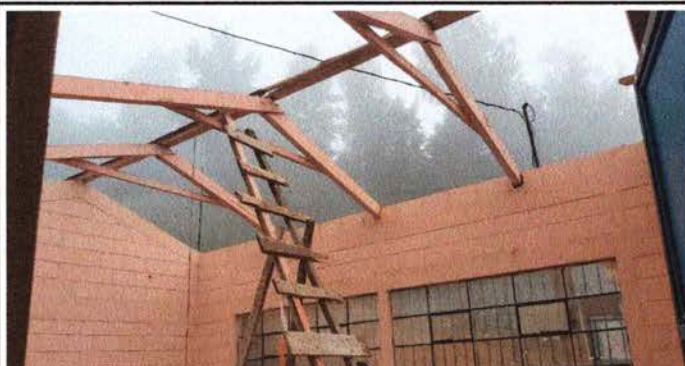
FOTO 3: SUSTITUCIÓN DE ESTRUCTURA DE MADERA POR METAL
