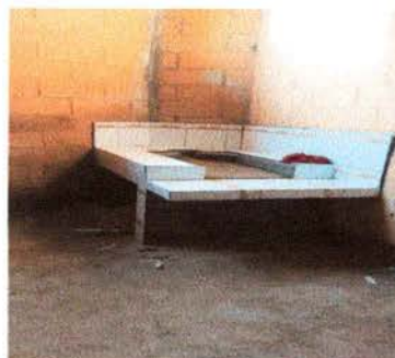
FOTO 10: REPARACION DE COCINA
