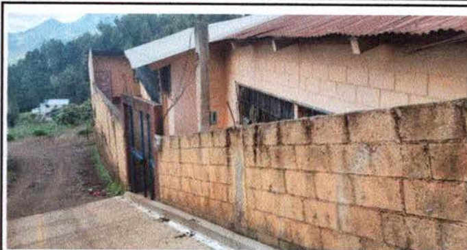
FOTO 8: PINTURA EN MUROS EXTERIORES E INTERIORES
