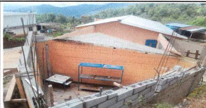
FOTO 2: SUSTITUCIÓN DE CAPOTE TROQUELADO Y LAMINA
