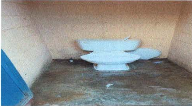
FOTO 13: SUSTITUCION DE INODORO
