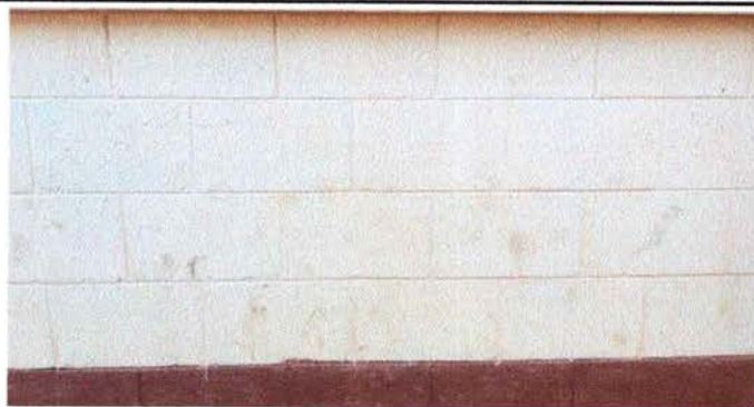
FOTO 7: PINTURA EN MUROS EXTERIORES E INTERIORES
