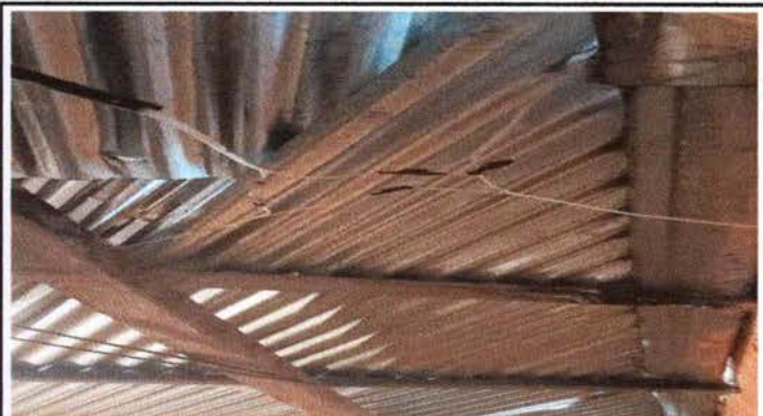
FOTO 16: REPARACION DEL SISTEMA ELECTRICO
