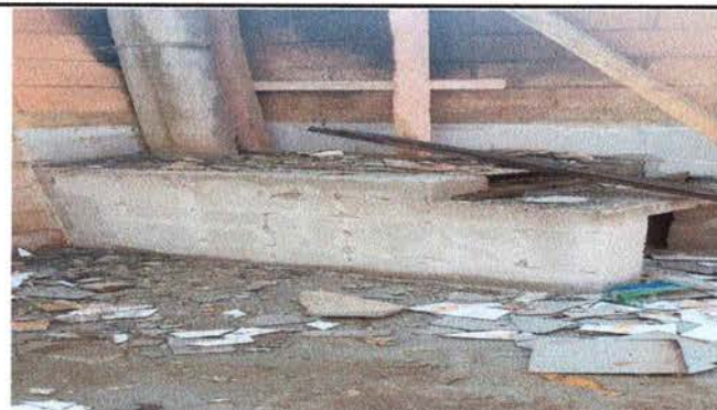
FOTO 9: REPARACION DE COCINA
