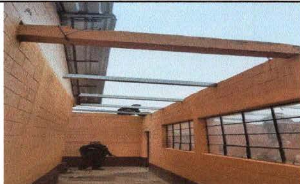
FOTO 4: MEJORAMIENTO DE BALCONES
