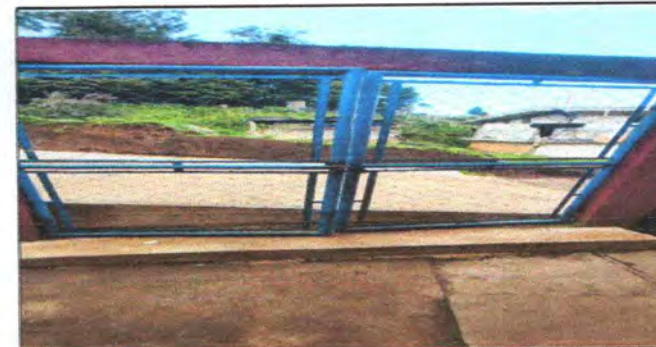
FOTO 6: SUSTITUCIÓN DE PORTON POR PORTON CORREDIZO
