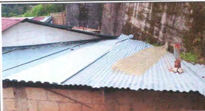
FOTO 1: SUSTITUCIÓN DE LAMINA A LAMINA TROQUELADA
