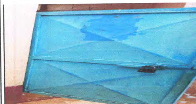
FOTO 5: MANTENIMIENTO DE PUERTAS, INCLUYE PINTURA
