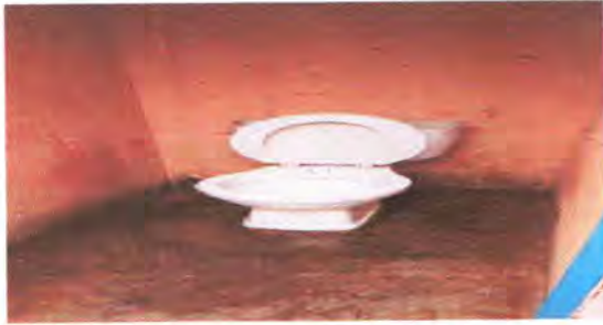
FOTO 1: SUSTITUCION DE INODORO
