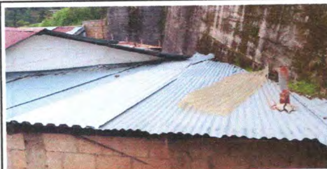
FOTO 5: MEJORAMIENTO DE PAREDES DE COCINA
