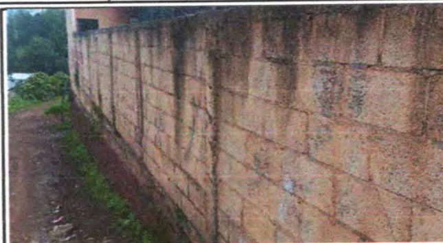
FOTO 2: PINTURA EN MUROS EXTERIORES E INTERIORES
