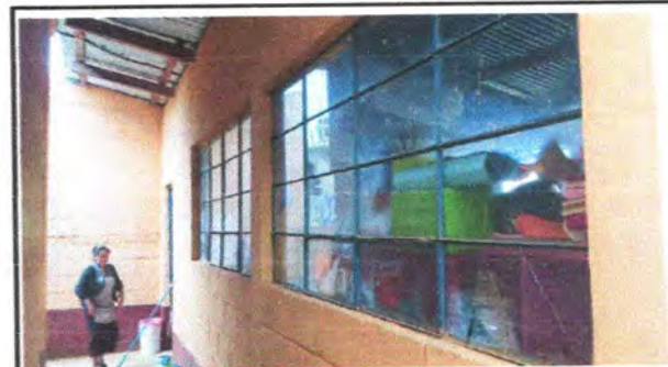
FOTO 4: MEJORAMIENTO DE BALCONES
