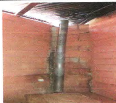
FOTO 4: REPARACION DE COCINA
