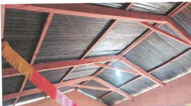
FOTO 3: SUSTITUCIÓN DE ESTRUCTURA DE MADERA POR METAL
