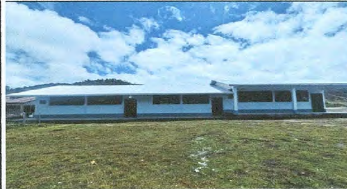
Foto 1: Sustitución de lámina por lámina troquelada calibre 26
