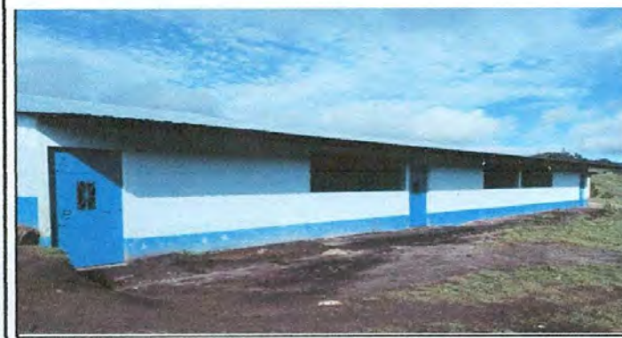
Foto 5: Sustitución de puertas
