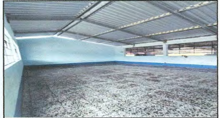
Foto 2: Sustitución de soporte de madera por metal
