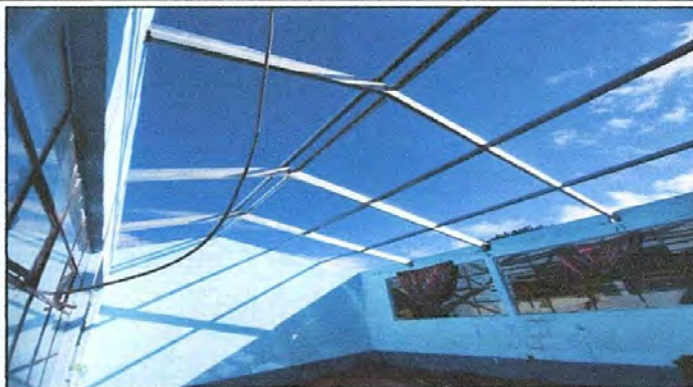
Foto 2: Sustitución de soporte de madera por metal
