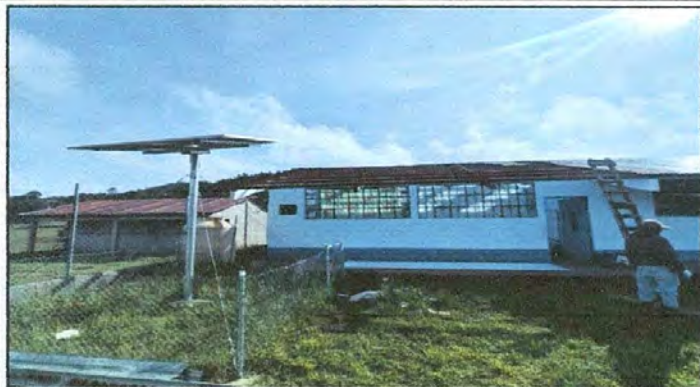
Foto 1: Sustitución de lámina por lámina troquelada calibre 26
