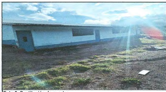
Foto 5: Sustitución de puertas
