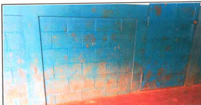
Foto 11: Pintura de muros exteriores
