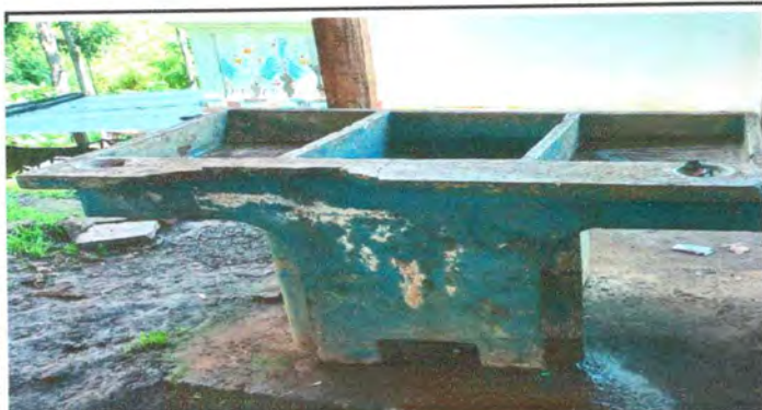
Foto 9: Sustitución de pila
