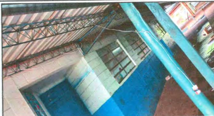
Foto 8: Reparación de sistema eléctrico
