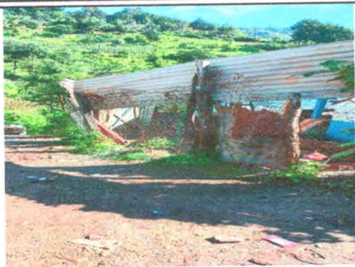
Foto7: Reparacion de tubo y malla galvanizada
