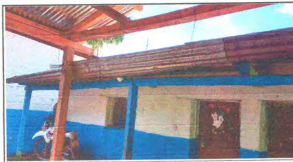
Foto 5: cambio de bajadas de agua y canales
