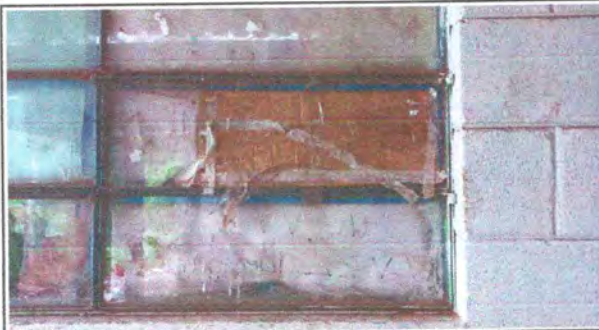
Foto 3: cambio de vidrios en ventanales.
