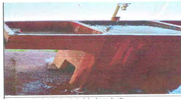
Foto 6: cambio de tubería principal de chorro de pila
