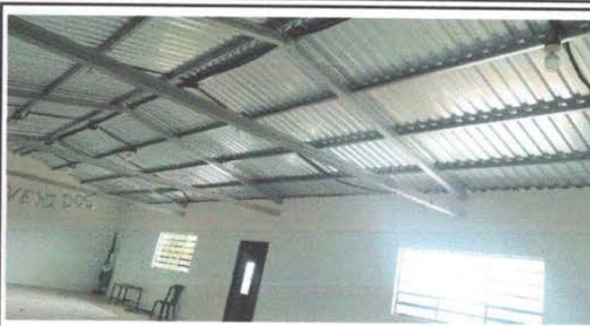
Foto 2: Mejoramiento de estructura de soporte de metal
