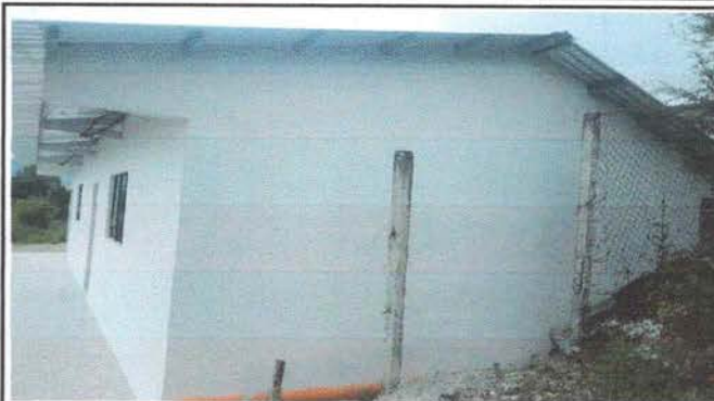
Foto 8: Mejoramiento de paredes de aula
