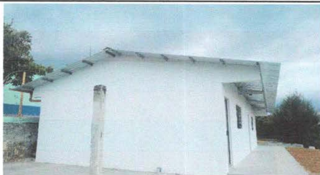
Foto 7: Mejoramiento de paredes de aula
