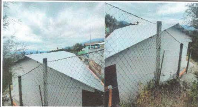
Foto1: Mejoramiento de lámina troquelada Aluzinc calibre 26
