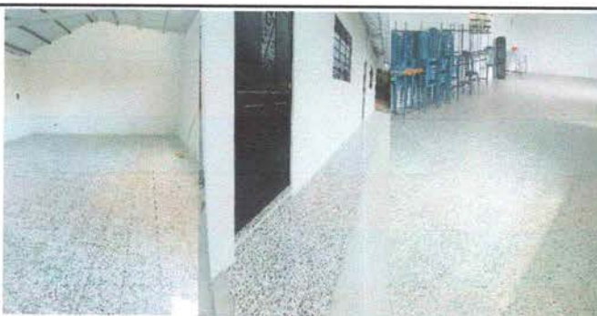
Foto 5: Mejoramiento de piso granito
