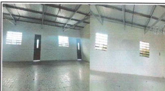
Foto 4: Mejoramiento a estructura de metal de ventanas con vidrios
