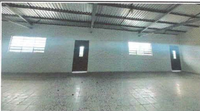
Foto 3: Mejoramiento de puerta de metal
