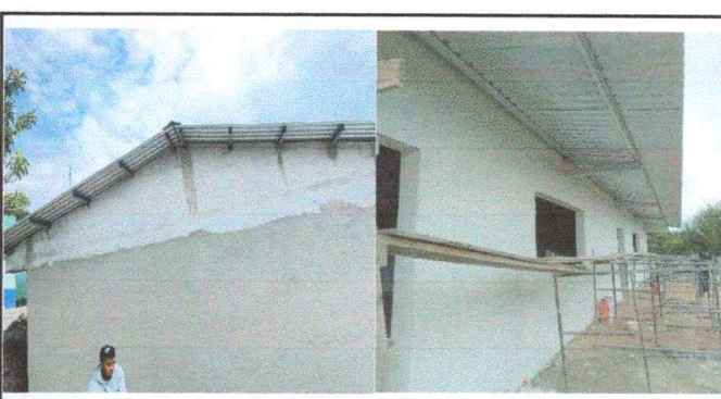
Foto 6: Mejoramiento de repello y cernido de paredes de aula
