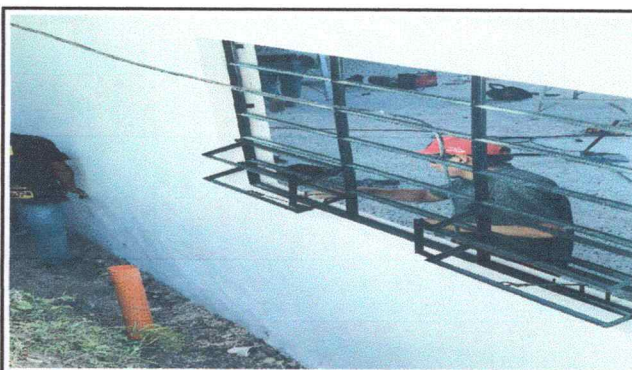
Foto 4: Mejoramiento a estructura de metal de ventanas con vidrios
