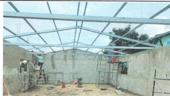
Foto 2: Mejoramiento de estructura de soporte de metal
