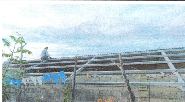
Foto 1: Mejoramiento de lámina troquelada Aluzinc calibre 26
