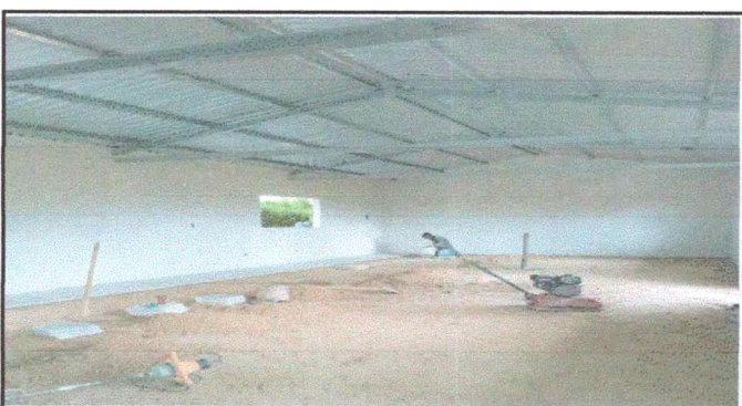
Foto 5: Mejoramiento de piso granito
