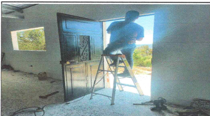
Foto 3: Mejoramiento de puerta de metal
