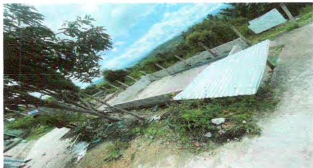
Foto1: Mejoramiento de lámina troquelada Aluzinc calibre 26
