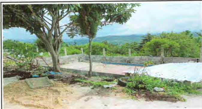
Foto 7: Mejoramiento de paredes de aula
