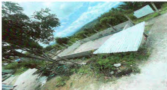
Foto 2: Mejoramiento de estructura de soporte de metal
