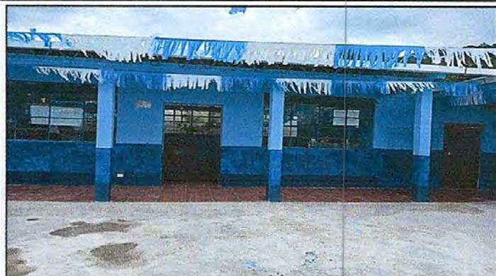
Foto 7: Pintura de muros exteriores e interiores
