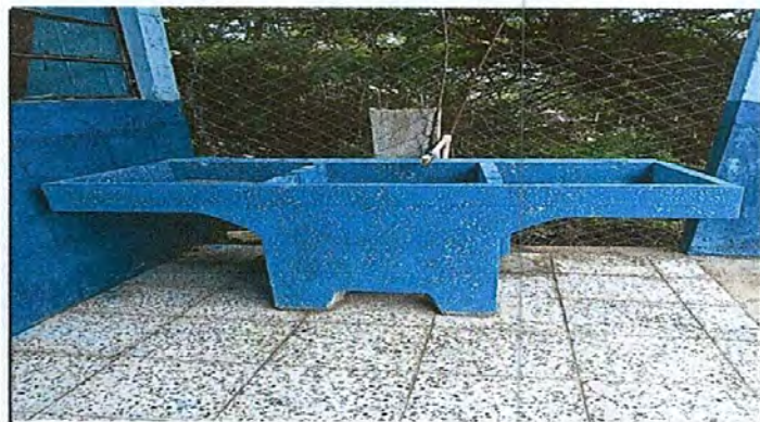
Foto 9: Reparación de Cocina
