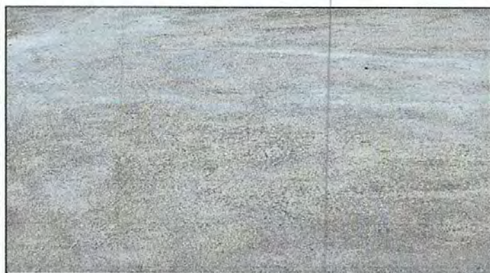
Foto 3: Losa de Patio
