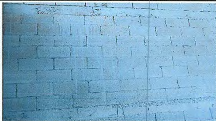
Foto 1: Reparación de Paredes de Aulas.
