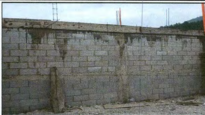
Foto 1: Reparación de Paredes de Aulas.
