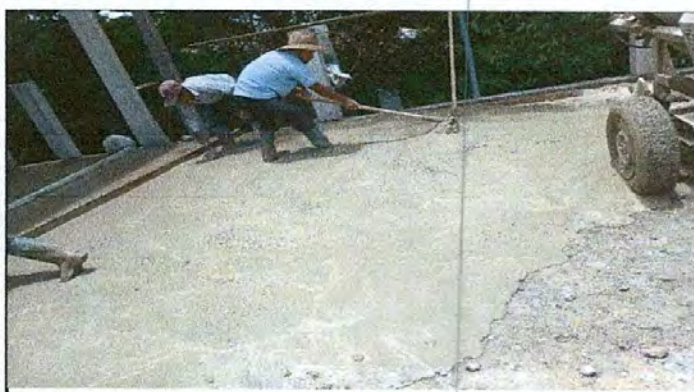
Foto 3: Losa de Patio
