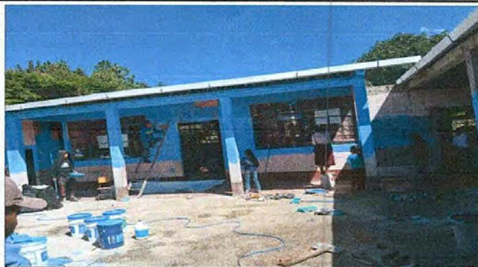
Foto 7: Pintura de muros exteriores e interiores
