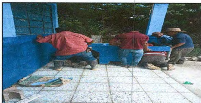
Foto 9: Reparación de Cocina
