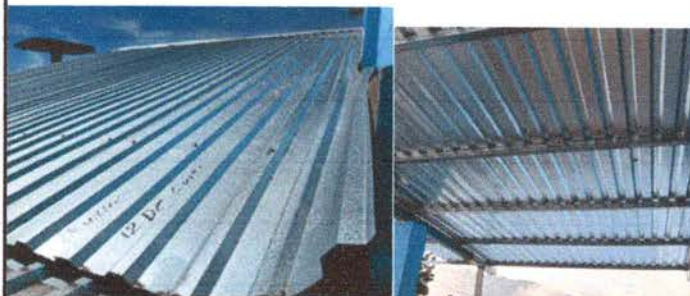
FOTO 1: SUSTITUCION DE LAMINA POR LAMINA TROQUELADA ALUNZINC CALIBRE 26 EN AULA Y ESPACIO DE GRADAS
