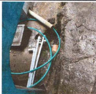
FOTO 8: SUSTITUCION DE TUBERIA LINEA PRINCIPAL
