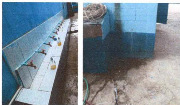
FOTO 9: SUSTITUCION DE CHORROS
