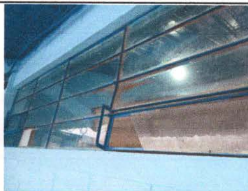
FOTO 4: MANTENIMIENTO A ESTRUCTURA DE METAL DE VENTANA
