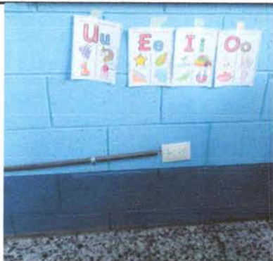
FOTO 13: SUSTITUCION DE TOMACORRIENTES DOBLES
