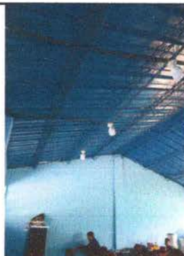
FOTO 10: SUSTITUCION DE LAMPARAS LED
