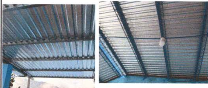
FOTO 3: SUSTITUCION DE ESTRUCTURA DE SOPORTE DE METAL POR METAL EN AULA Y ESPACIO DE GRADAS
