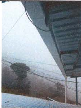
FOTO 7: SUSTITUCION DE CANALES DE METAL POR PVC
