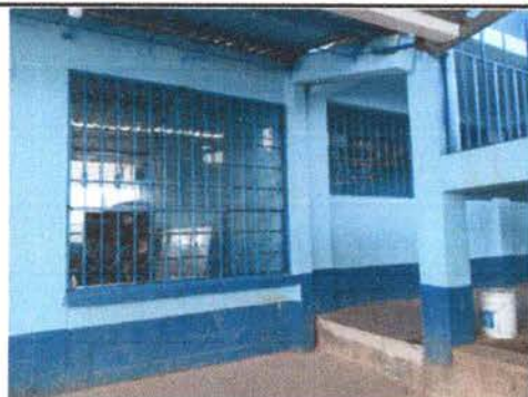
FOTO 5: MEJORAMIENTO DE BALCONES
