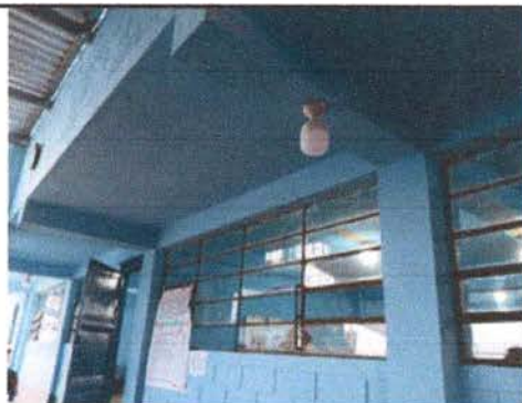
FOTO 11: SUSTITUCION DE PLAFONERAS
