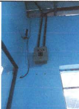
FOTO 15: SUSTITUCION DE TABLEROS DE FLIPONES
