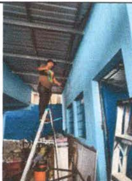
FOTO 17: SUSTITUCION DE DUCTO ELECTRICO MAS ACCESORIOS
