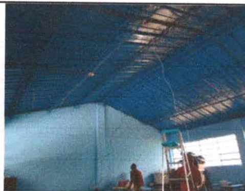
FOTO 10: SUSTITUCION DE LAMPARAS LED
