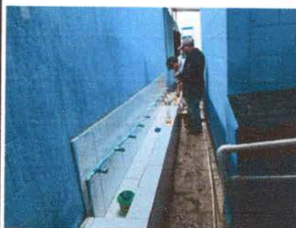
FOTO 9: SUSTITUCION DE CHORROS
