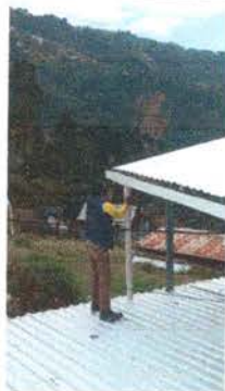
FOTO 7: SUSTITUCION DE CANAL DE METAL POR PCV
