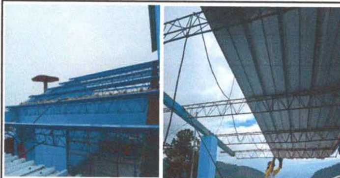
FOTO 1: SUSTITUCION DE LAMINA POR LAMINA TROQUELADA ALUNZINC CALIBRE 26 EN AULA Y ESPACIO DE GRADAS
