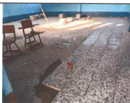
FOTO 6: SUSTITUCION DE PISO DE CONCRETO POR PISO DE GRANITO
