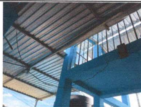
FOTO 16: REPARACION DE CABLEADO ELECTRICO
