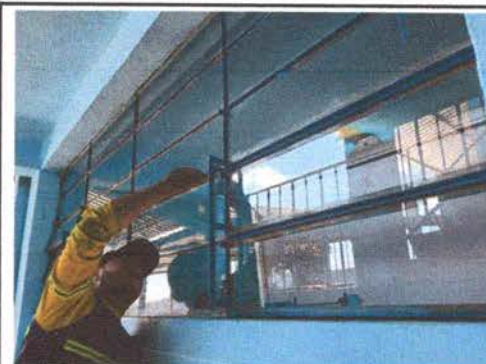
FOTO 4: MANTENIMIENTO A ESTRUCTURA DE METAL DE VENTANA
