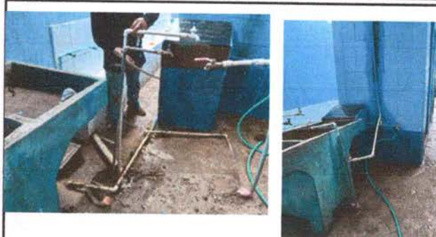
FOTO 8: SUSTITUCION DE TUBERIA LINEA PRINCIPAL
