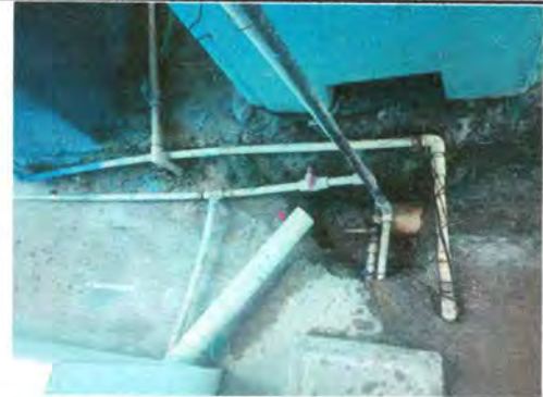
FOTO 8: SUSTITUCION DE TUBERIA LINEA PRINCIPAL
