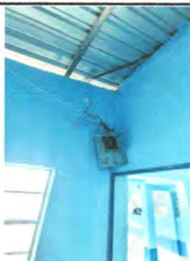
FOTO 15: SUSTITUCION DE TABLEROS DE FLIPONES
