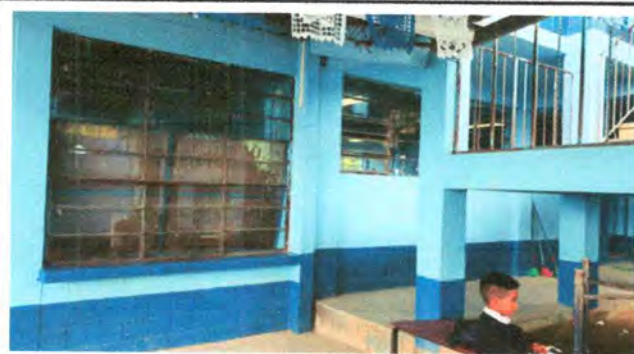
FOTO 5: MEJORAMIENTO DE BALCONES
