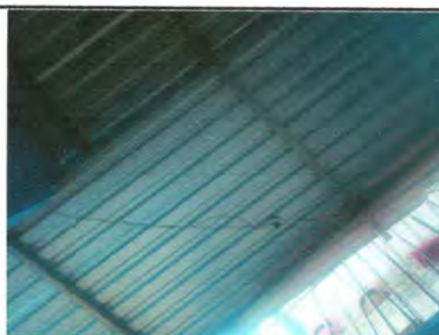
FOTO 16: REPARACION DE CABLEADO ELECTRICO
