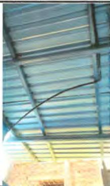
FOTO 17: SUSTITUCION DE DUCTO ELECTRICO MAS ACCESORIOS
