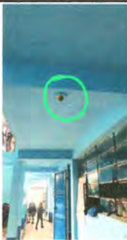
FOTO 11: SUSTITUCION DE PLAFONERAS
