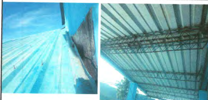
FOTO 1: SUSTITUCION DE LAMINA POR LAMINA TROQUELADA ALUNZINC CALIBRE 26 EN AULA Y ESPACIO DE GRADAS
