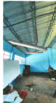
FOTO 10: SUSTITUCION DE LAMPARAS LED
