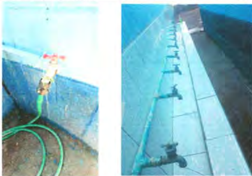
FOTO 9: SUSTITUCION DE CHORROS
