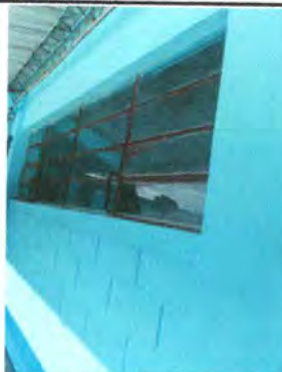
FOTO 4: MANTENIMIENTO A ESTRUCTURA DE METAL DE VENTANA
