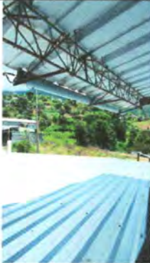
FOTO 7: SUSTITUCION DE CANAL DE METAL POR PVC
