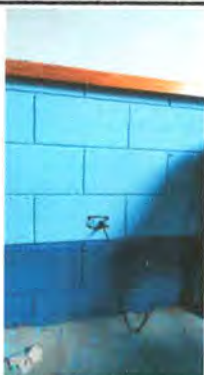
FOTO 13: SUSTITUCION DE TOMACORRIENTES DOBLES
