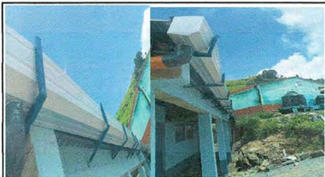
FOTO 4: Sustrucción de canal de metal y sustustrucción de bajada de agua pluvial tubo PVC 4"
