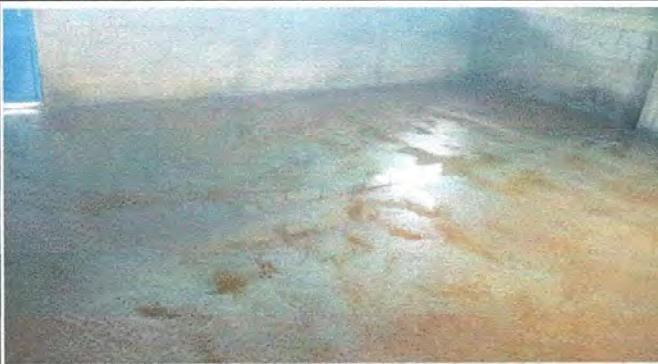
FOTO 9: Sustrucion de torta de cemento
