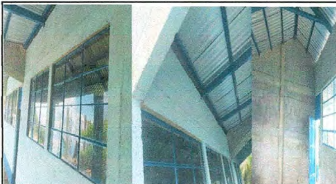
FOTO 2: Sustrucción de estructura de soporte y mejoramiento de pared y soporte de mojinete del techo
