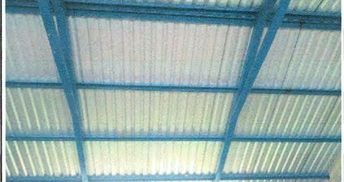
FOTO 2: Sustrucción de estructura de soporte y mejoramiento de pared y soporte de mojinete del techo
