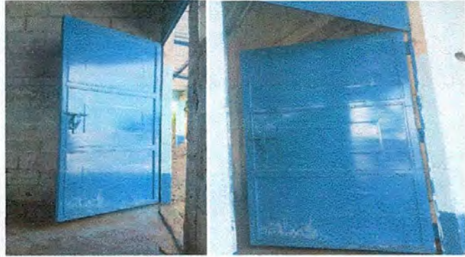
FOTO 7: Sustrucion de puerta de metal
