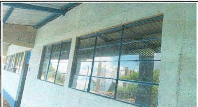
FOTO 3: Sustrucción de estructura de metal de ventanas con vidreos
