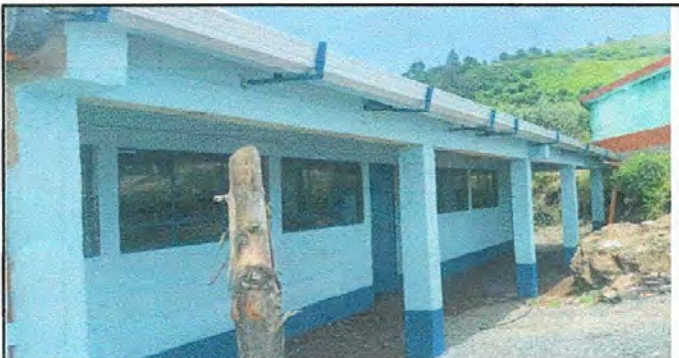
FOTO 5: Pintura de muros exteriores e interiores
