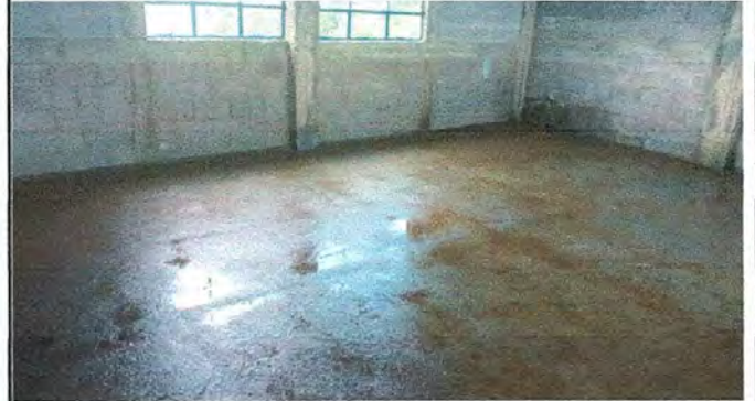
FOTO 8: Sustrucion de torta de cemento
