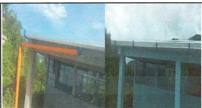
FOTO 4: Sustitución de canal de metal y sustitución de bajada de agua pluvial tubo PVC 4"
