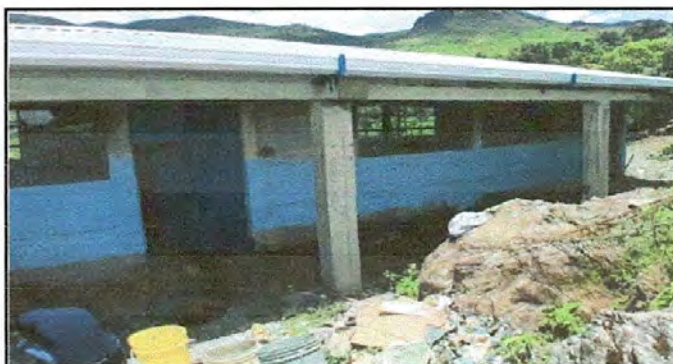
FOTO 5: Pintura de muros exteriores e interiores
