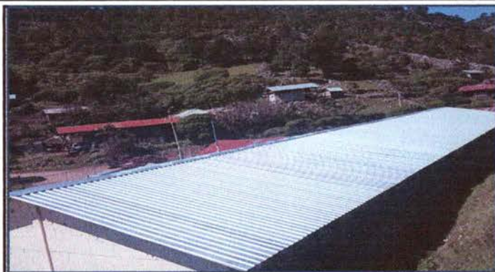
Foto1: Sustitución de lámina por lámina troquelada
