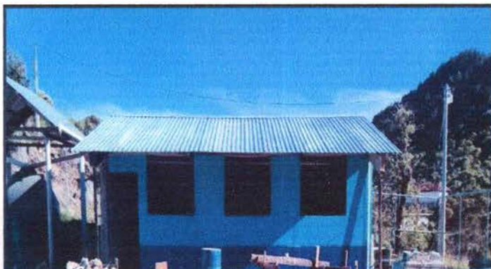
Foto 3: Sustitución de lámina por lámina troquelada
