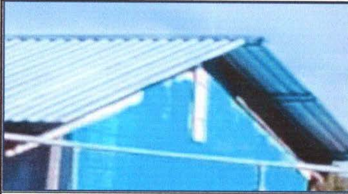
Mejoramiento de pared y soporte del mojinete del techo
