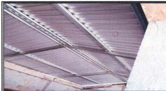
Foto 4: Sustitución de soporte de madera a metal
