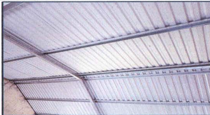
Foto 2: Sustitución de soporte de metal a metal
