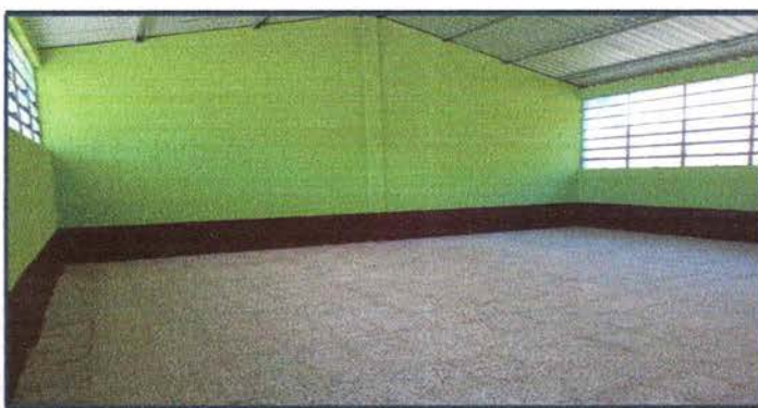
Foto 7: Sustitución de piso de torta de concreto
