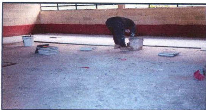
Foto 7: Sustitución de piso de torta de concreto
