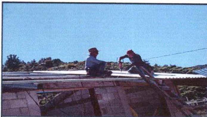
Foto 3: Sustitución de lámina por lámina troquelada
