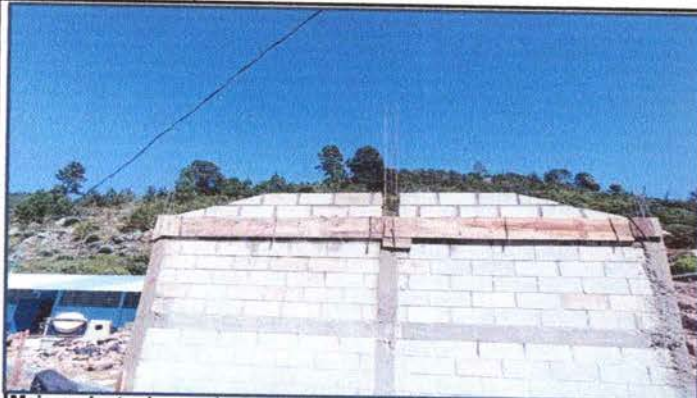
Mejoramiento de pared y soporte del mojinete del techo
