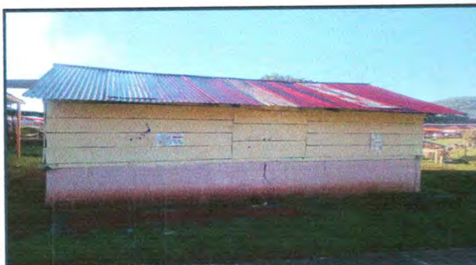
Foto 3: Sustitución de lámina por lámina troquelada
