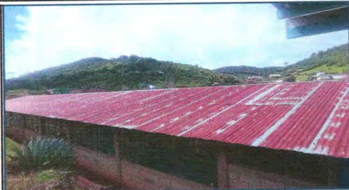
Foto1: Sustitución de lámina por lámina troquelada
