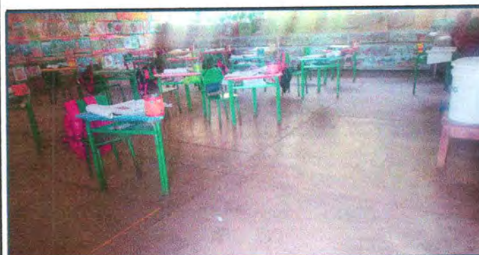
Foto 7: Sustitución de piso de torta de concreto
