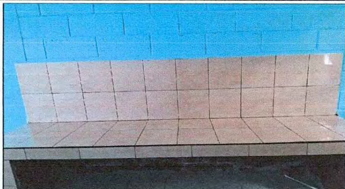
Foto 1: Colocación de cerámico en cocina
