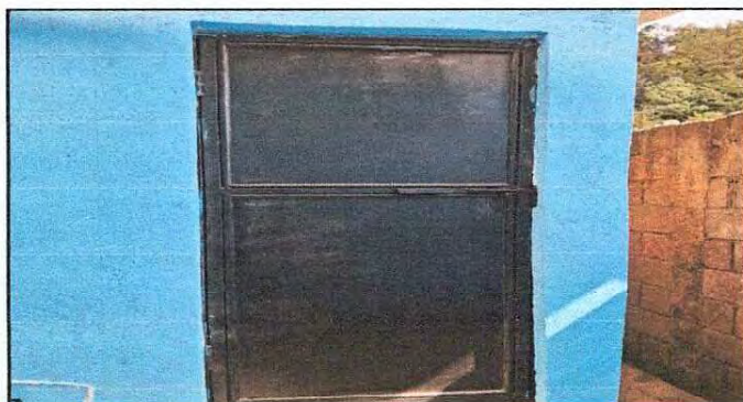
Foto 3: Instalación de puerta de baño.
