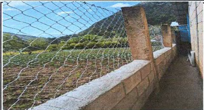
Foto 7: Colocación de malla en muro.
