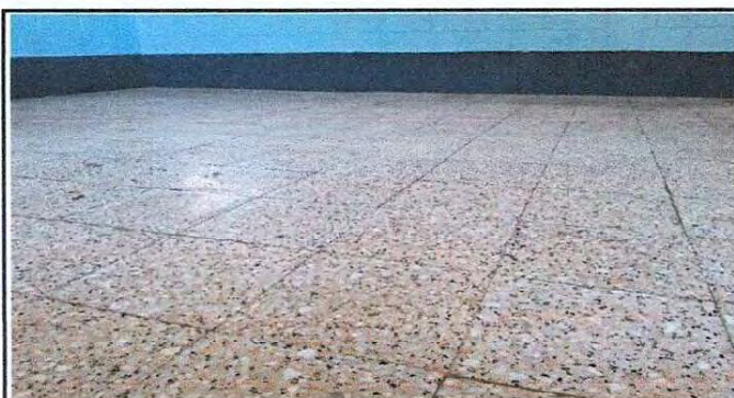
Foto 9: Colocación de granito en aula.
