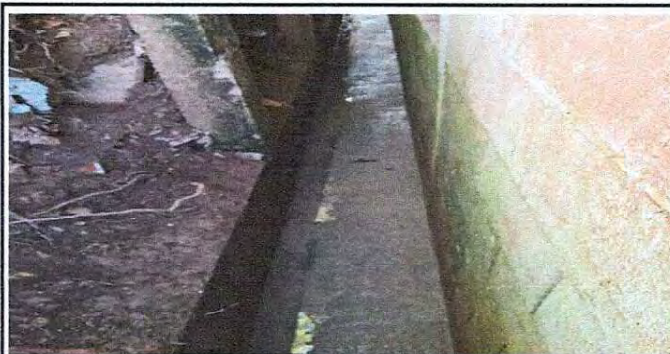
Foto 15: Limpieza de cuneta y pared, para levantar muro.
