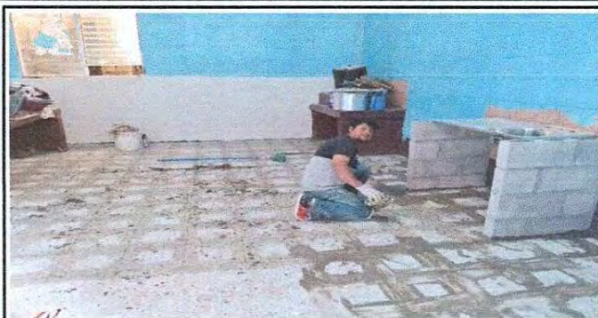
Foto7: Colocación de lavatrastos en la cocina, cisando el piso granito
