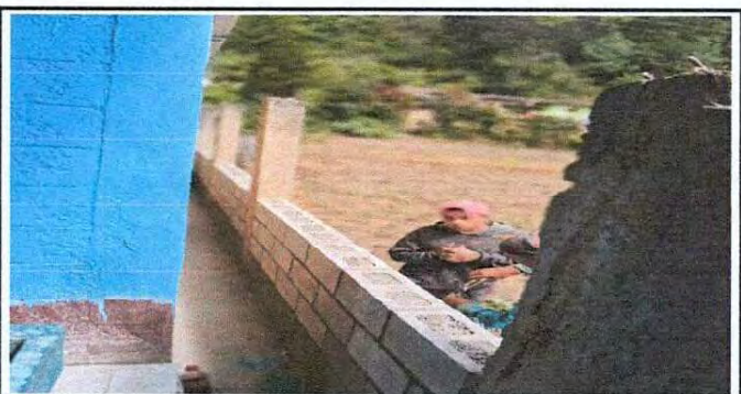
Foto 5: Iniciando a levantar muro
