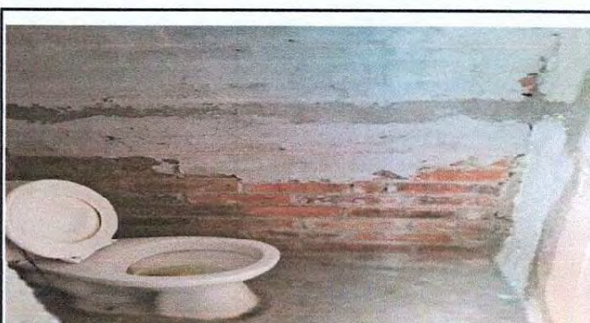
Foto 4: Tallando paredes del baño
