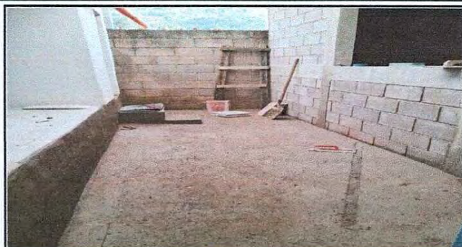
Foto 8: Fundicion de torta de cemento en aula y pasillo.
