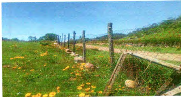
Foto 3: reparacion de tubo hg y malla galvanizada
