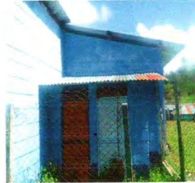
Foto 2: Sustitución de lámina por lámina troquelada calibre 26, Sustitución de elementos de fijacion
