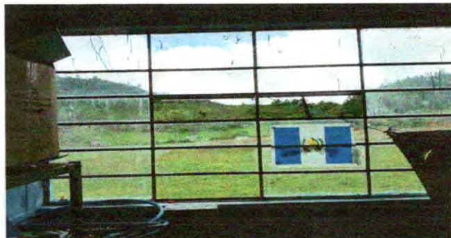
Foto 8: sustitucion de vidrios
