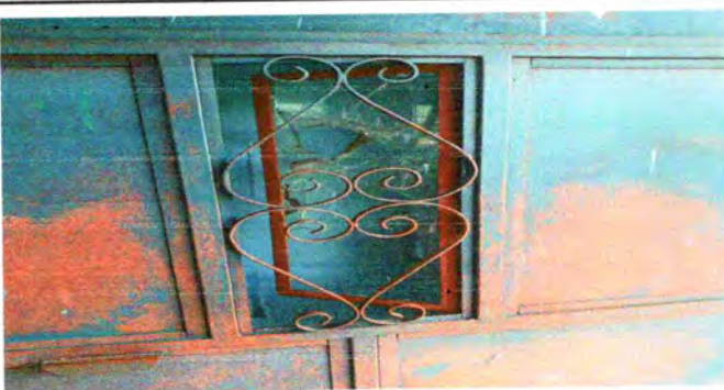
Foto 5: Sustitución de puertas
