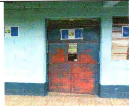
Foto 6: Sustitución de puertas
