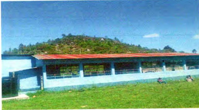
Foto 1: sustitucion de lámina por lámina troquelada calibre 26, Sustitución de capote de lámina para lámina troquelada, Sustitucion de elementos de fijacion
