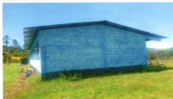
Foto 10: pintura en muros exteriores e interiores
