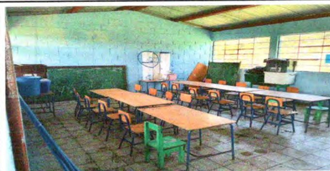
Foto 11: Pintura en muros exteriores e interiores
