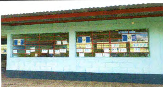
Foto 9: Mejoramiento de balcones de metal
