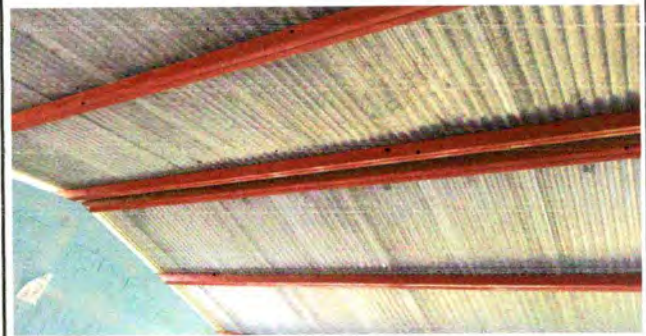
Foto 4: Mantenimiento a estructura de soporte de metal
