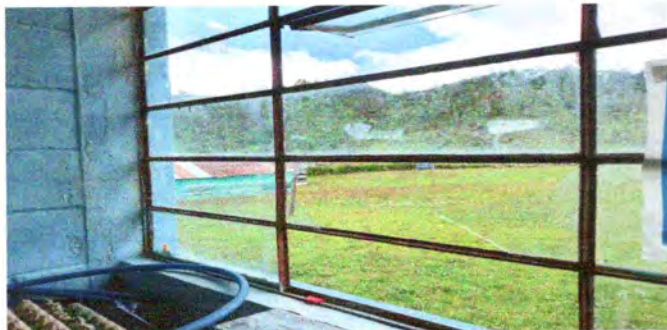
Foto 7: sustitucion de vidrios
