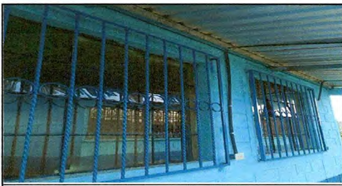
Foto 5: Sustitución de vidrios
