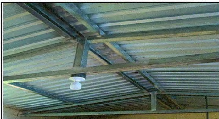
Foto1: Sustitución de lámina troquelada aluzinccalibre 26
