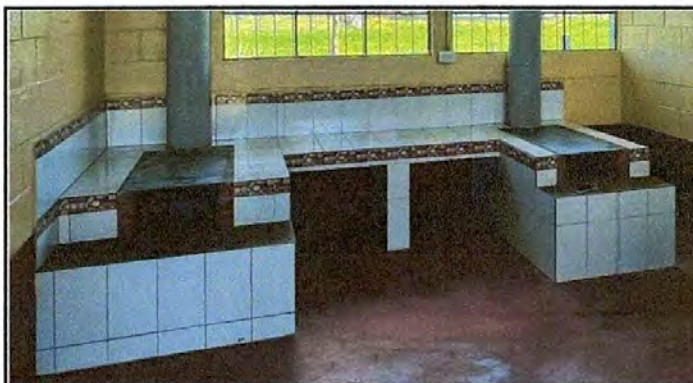
Foto 10: Sustitución de estufa rural (completa) incluye chimenea y plancha de metal e instalación de azulejo en estufa rural
