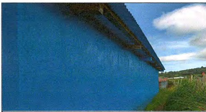
Foto 11: Repello, cernido y alisado de una pared de dos aulas
