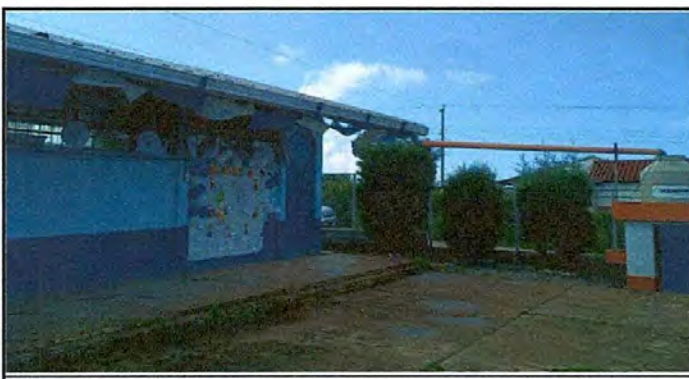
Foto 6: Sustitución de canal de metal y sustitución de bajada de agua pluvial de metal por tubo PVC 4"
