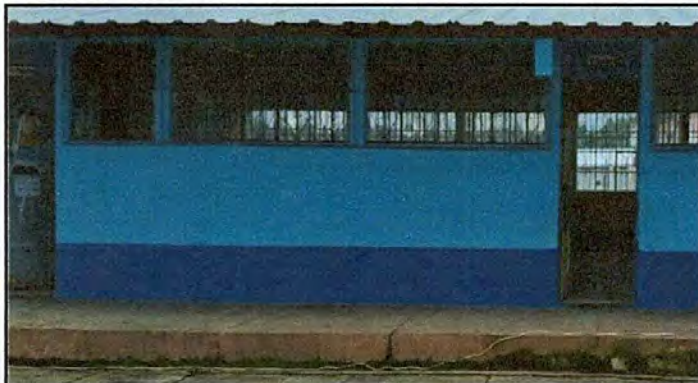
Foto 7: Pintura de muros exteriores e interiores
