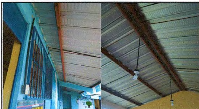
Foto 9: Sustitución de cableado eléctrico
