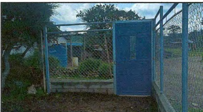
Foto 4: Sustitución de puerta de madera por puerta de metal
