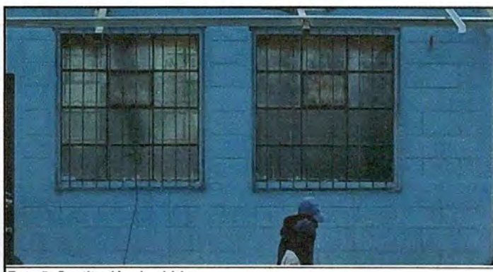
Foto 5: Sustitución de vidrios
