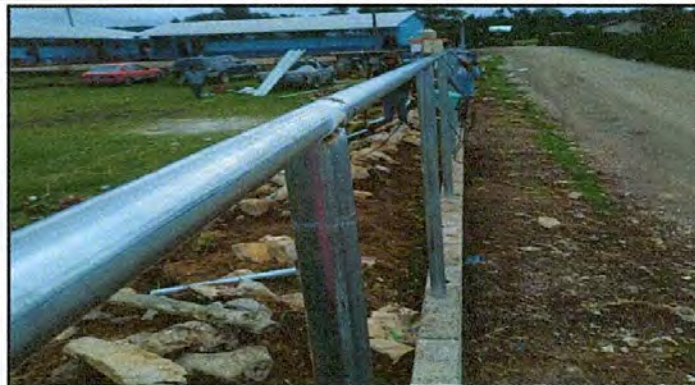
Foto 8: Sustitución de cerco de madera y malla por tubo hg y malla galvanizada
