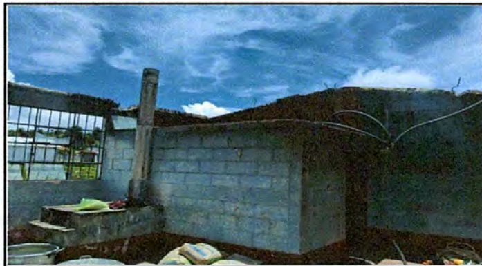
Foto1: Sustitución de lámina troquelada aluzinccalibre 26
