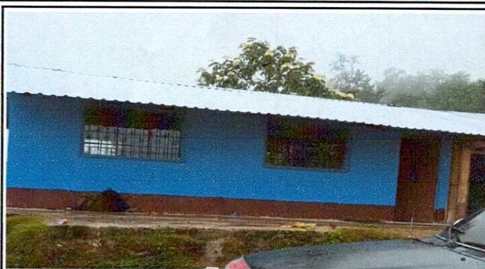
Foto 2: Terminacion de techo y balcones
