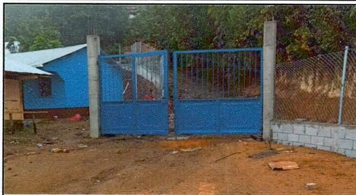
Foto1: Conclusion y colocacion del porton
