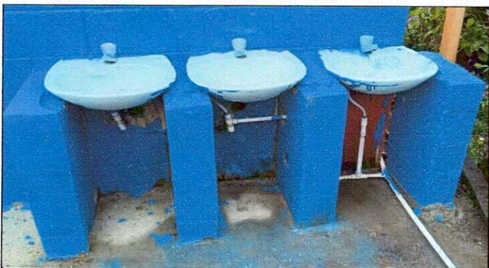
Foto 3: Instalacion completada de lavamanos
