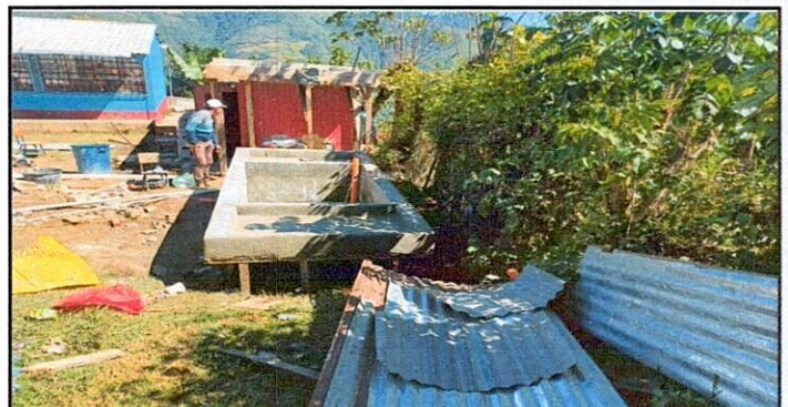
Foto 6: Instalacion y construccion de pila
