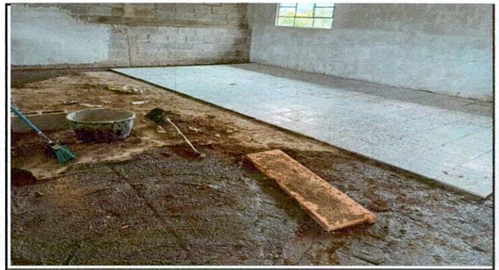
Foto 4: Colocacion de piso de granito en aula
