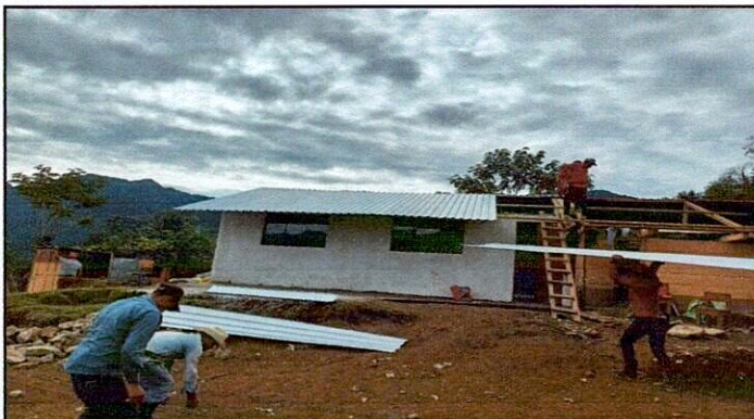
Foto 3: Colocación de techo para aula
