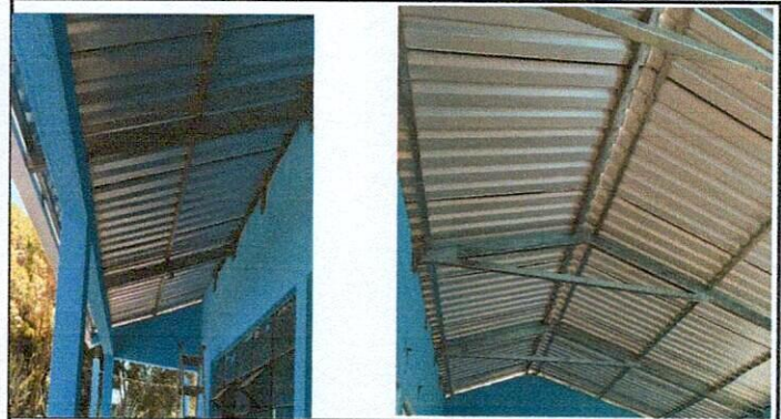
Foto 2: Estructura de techo: Sustitución de estructura de soporte de madera por metal
