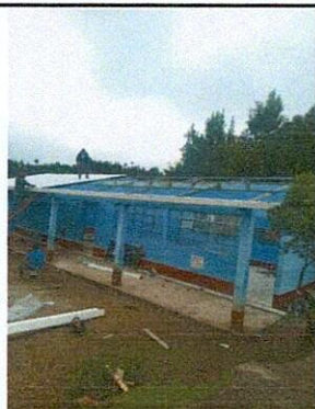
Foto1: cubierta de lamina:Sustitución de lamina troquelada calibre 26
