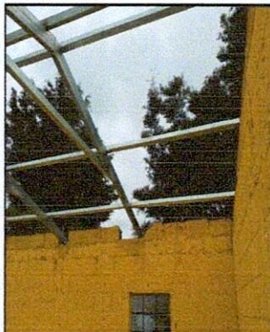
Foto 2: Estructura de techo: Sustitución de estructura de soporte de madera por metal
