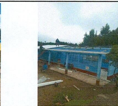
Foto1: cubierta de lamina:Sustitución de lamina troquelada calibre 26
