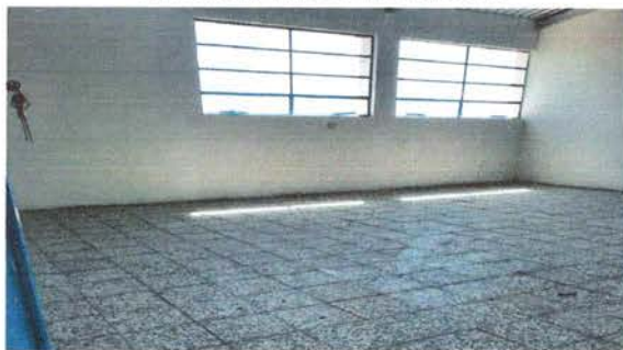
Foto 11: MEJORAMIENTO DE MURO DE AULA
