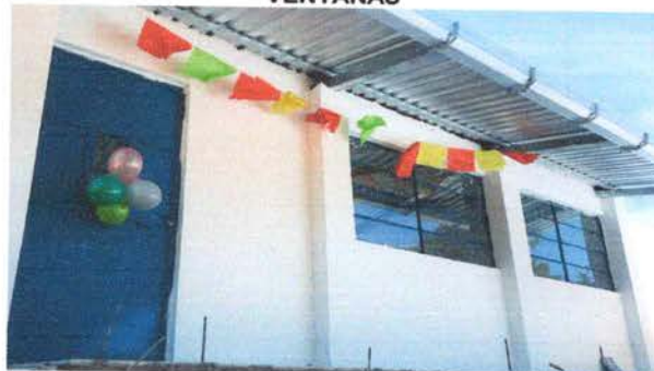
Foto 4: MEJORAMIENTO DE VENTANALES DE METAL Y VIDRIOS
