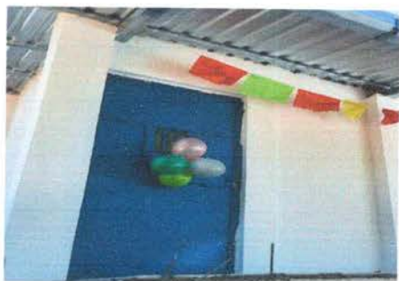
Foto 3: MEJORAMIENTO DE PUERTA DE METAL
