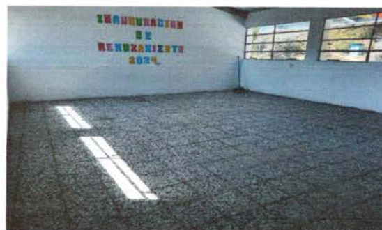
Foto 10: CERNIDO DE MURO
