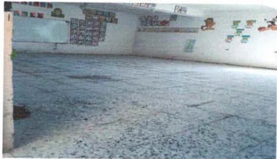
Foto 5: MEJORAMIENTO DE PISO GRANITO
