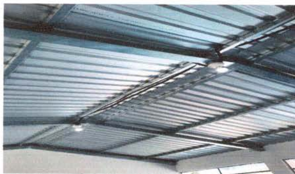
Foto 8: MEJORAMIENTO DEL SISTEMA ELECTRICO, FOCOS, PLAFONERAS, INTERRUPTORES DOBLES, TOMACORRIENTES DOBLES, SUSTITUCION DE DUCTOS MAS ACCESORIOS
