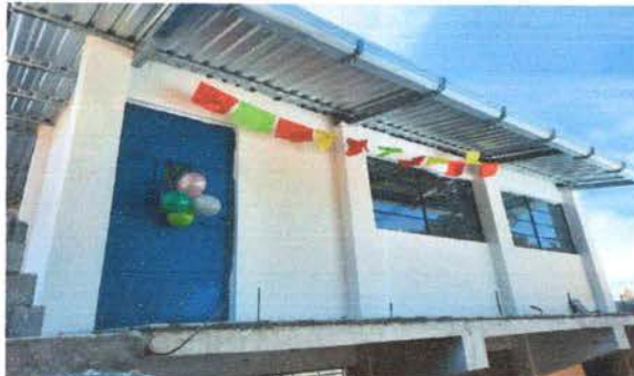
Foto7: MEJORAMIENTO DE CANAL DE METAL Y BAJAS DE AGUA, EN TUBOS PVC DE 3"
