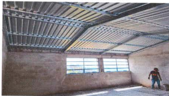
Foto 2: MEJORAMIENTO DE ESTRUCTURA DE TECHO
