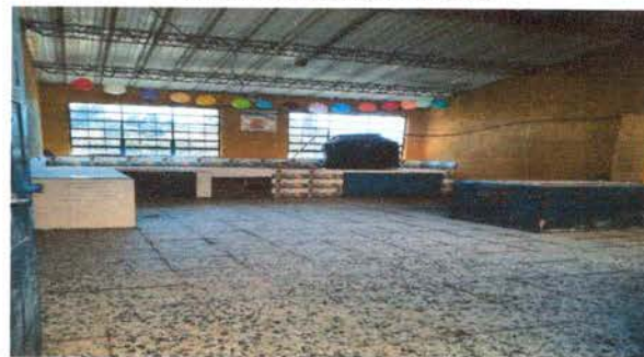
Foto 12: SUSTITUCIÓN DE PISO GRANITO
