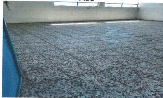
Foto 6: MEJORAMIENTO DE PISO GRANITO
