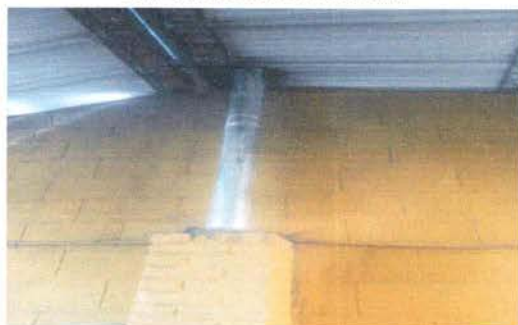
Foto 9: MEJORAMIENTO DE CHIMINEA DE METAL
