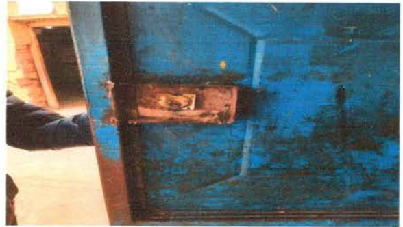
FOTO 14. SUSTITUCIÓN DE CHAPAS
