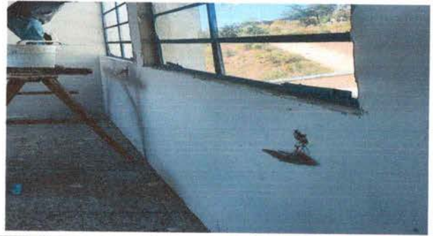
Foto 8: MEJORAMIENTO DEL SISTEMA ELECTRICO, FOCOS, PLAFONERAS, INTERRUPTORES DOBLES, TOMACORRIENTES DOBLES, SUSTITUCION DE DUCTOS MAS ACCESORIOS
