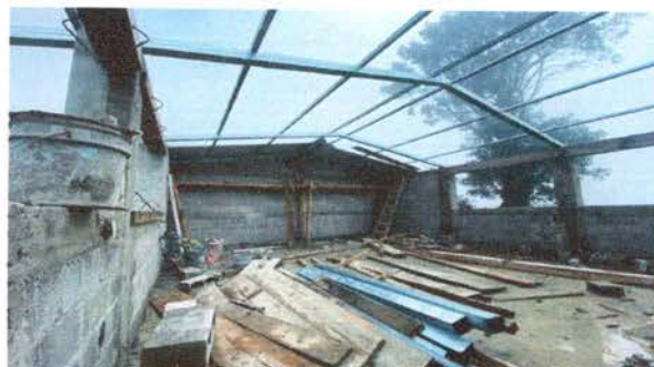
Foto 2: MEJORAMIENTO DE ESTRUCTURA DE TECHO
