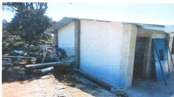
Foto 3: MEJORAMIENTO DE PUERTA DE METAL
