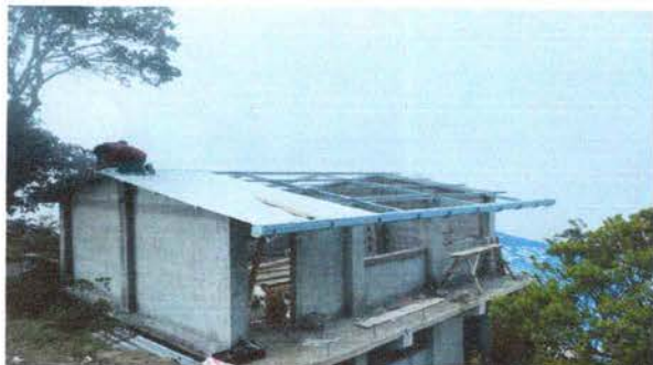
Foto1: MEJORAMIENTO DE TECHO DE LAMINA TROQUELADA, ALUZINC, CALIBRE 26
