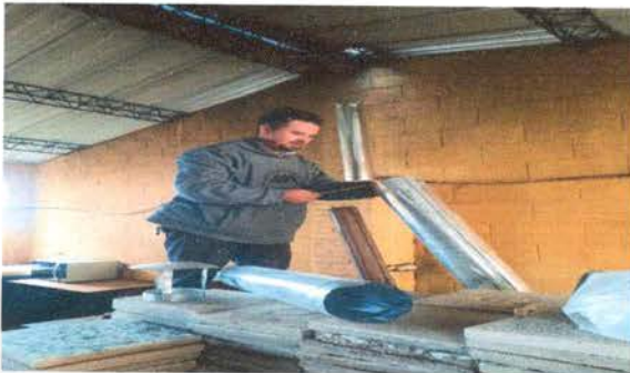
Foto 9: MEJORAMIENTO DE CHIMINEA DE METAL DE 3 M
