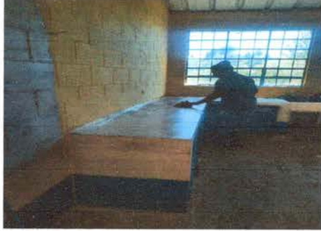
Foto13: MEJORAMIENTO DE AZULEJO EN MUEBLES DE COCINA
