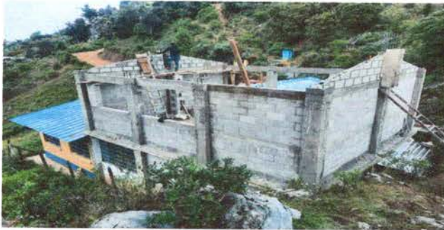
Foto 11: MEJORAMIENTO DE MURO DE AULA
