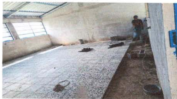
Foto 6: MEJORAMIENTO DE PISO GRANITO
