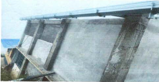
Foto 7: MEJORAMIENTO DE CANAL DE METAL Y BAJAS DE AGUA PLUVIAL, TUBOS PVC DE 3"
