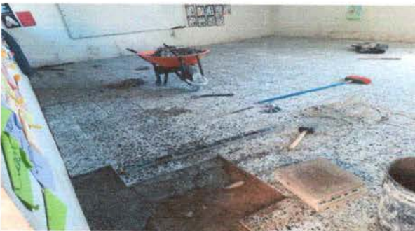
Foto 5: SUSTITUCIÓN DE PISO GRANITO
