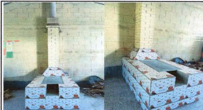
Foto 14: Sustitución de azulejo en estufa rural
