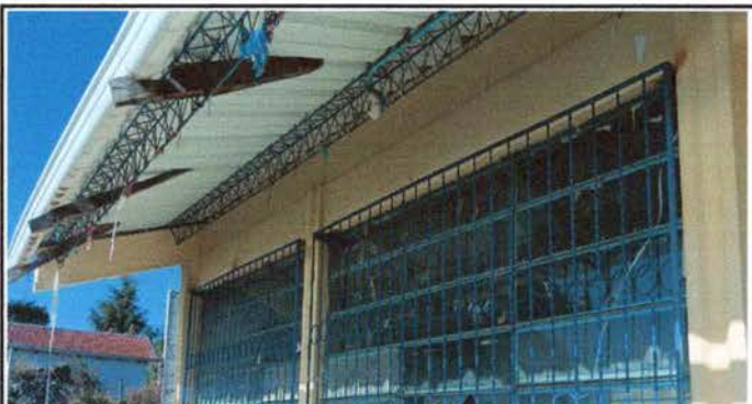
Foto 15: Mejoramiento de balcones de metal
