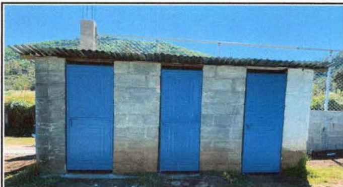
Foto 16: Sustitución de puerta de metal de baños
