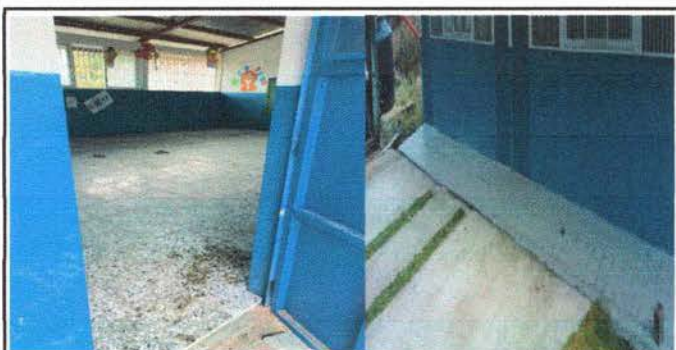
Foto 5: Sustitución de piso de torta de cemento por piso granito
