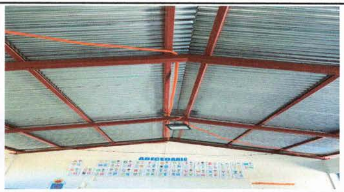
Foto 10: Sustitución de ducto electrico mas accesorios
