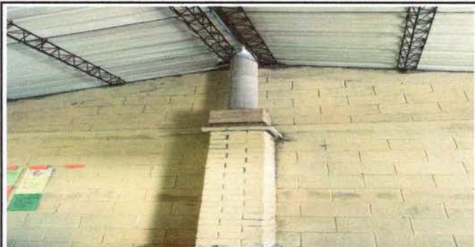
Foto 13: Sustitución de chimenea de metal
