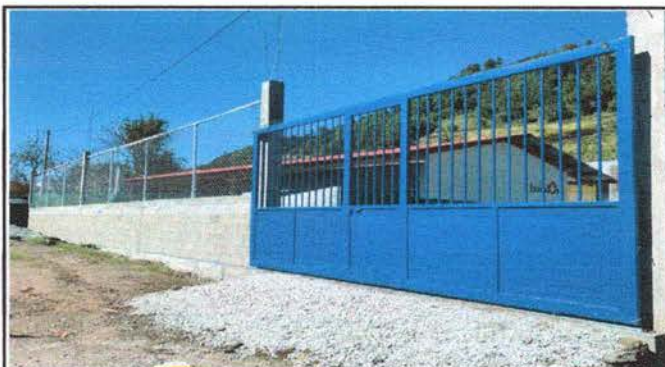
Foto 4: Sustitución de porton de metal
