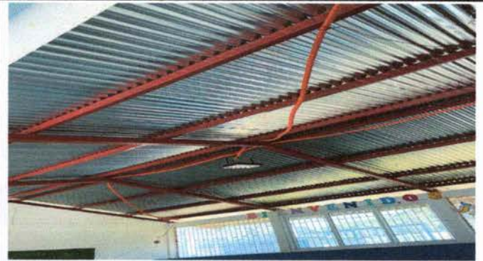
Foto 8: Reparacion de cableado electrico
