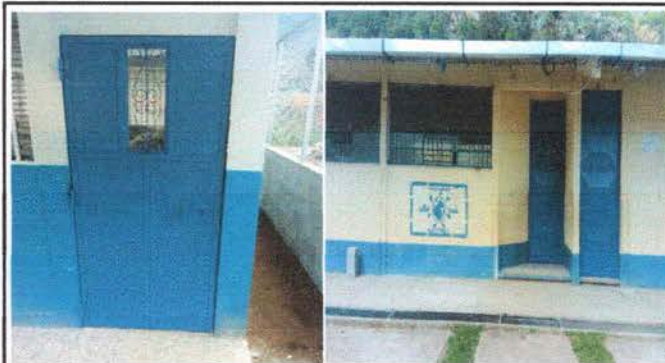
Foto 2: Sustitución de puerta de metal
