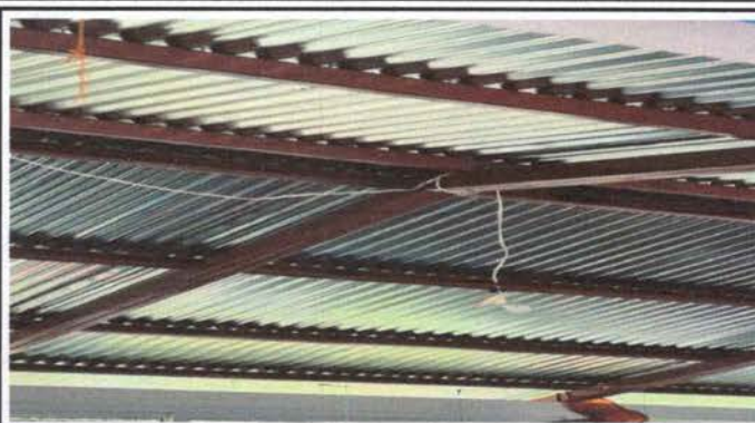
Foto 8: Reparación de cableado eléctrico
