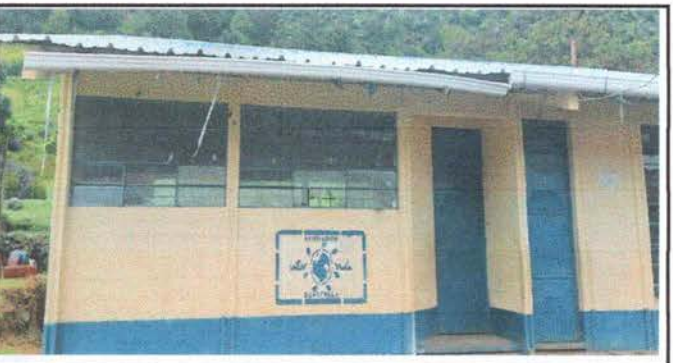
Foto 6: Sustitución de canal de metal
