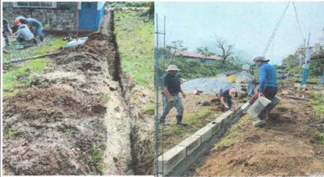
Foto1: Sustitución de muro perimetral de postes de madera y malla por muro perimetral de block con tubo hg y malla galvanizada, soleras intermedias y columnas
