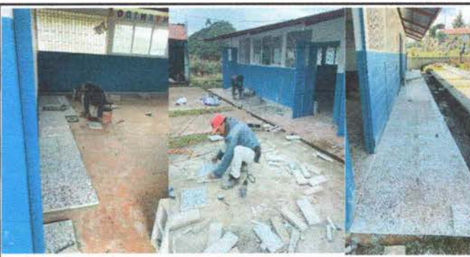
Foto 5: Sustitución de piso de torta de cemento por piso granito
