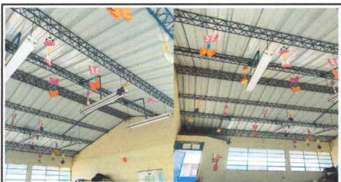
Foto 11: Sustitución de reflectores led de 100 wats
