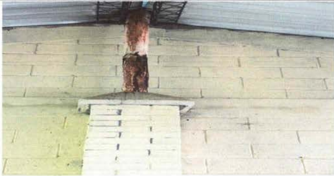
Foto 13: Sustrucción de chimenea de metal
