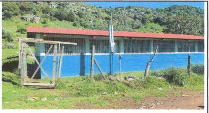
Foto 4: Sustitución de porton de metal
