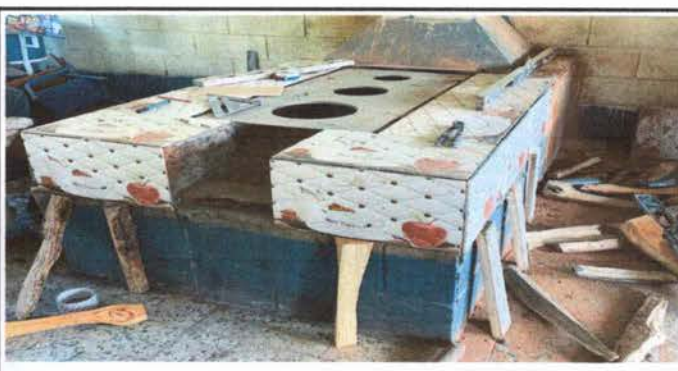
Foto 12: Sustitución de plancha de metal de 3 hornillas
