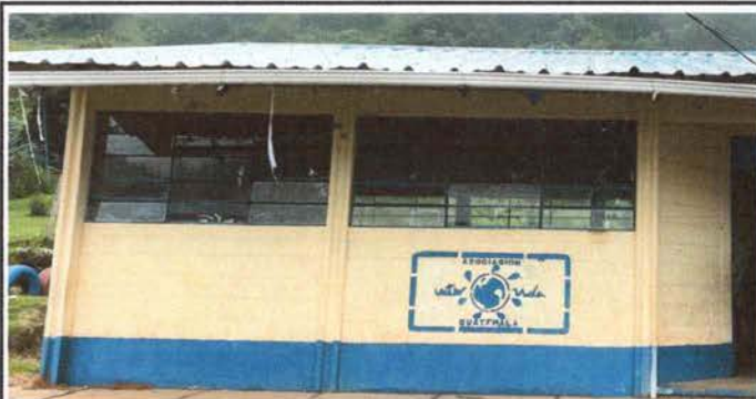
Foto 15: Mejoramiento de balcones de metal
