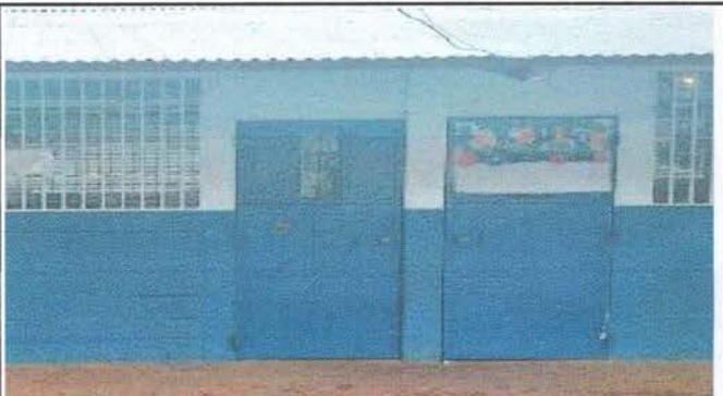
Foto 3: Mantenimiento de estructura de puertas de metal (corte, lijado, cepillado, pintura)
