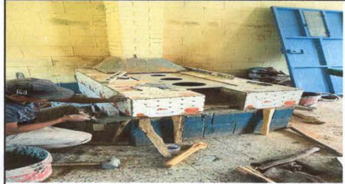
Foto 14: Sustrucción de azulejo en estufa rural
