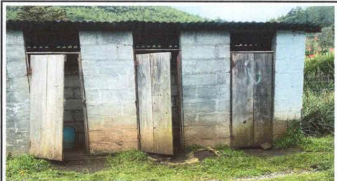
Foto 16: Sustrucción de puerta de metal de baños
