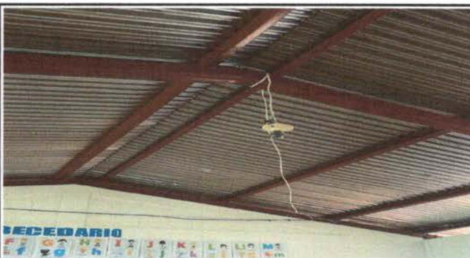
Foto 10: Sustitución de ducto eléctrico más accesorios
