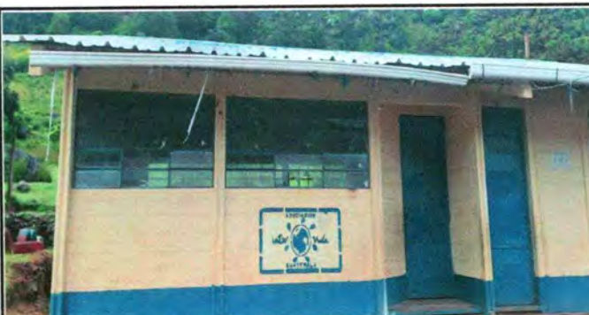
Foto 6: Sustrucción de canal de metal
