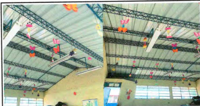
Foto 11: Sustitución de reflectores led de 100 wats
