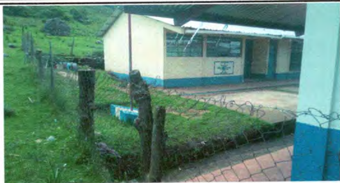
Foto 1: Sustrucción de muro perimetral de postes de madera y malla por muro perimetral de block con tubo hg y malla galvanizada, soleras intermedias y columnas
