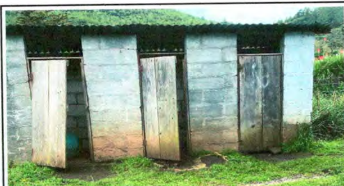
Foto 16: Sustrucción de puerta de metal de baños
