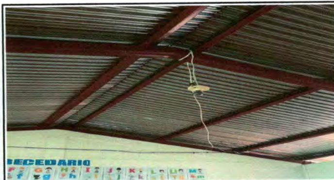
Foto 10: Sustitución de ducto eléctrico más accesorios
