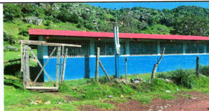
Foto 4: Sustrucción de porton de metal
