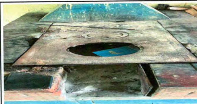
Foto 12: Sustitución de plancha de metal de 3 hornillas
