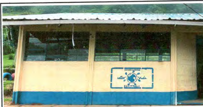
Foto 15: Mejoramiento de balcones de metal
