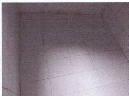
Foto 5: Se colocó azulejo en cisterna.
