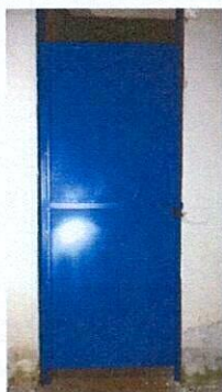
Foto 3. Se sustituyó puertas de metal en servicios sanitarios.
