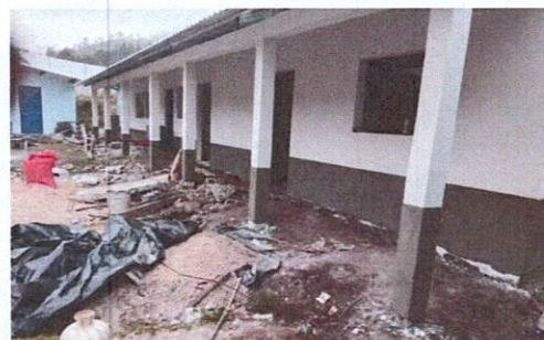
Foto 10. Se levantaron muros de contención para aula y cocina.
