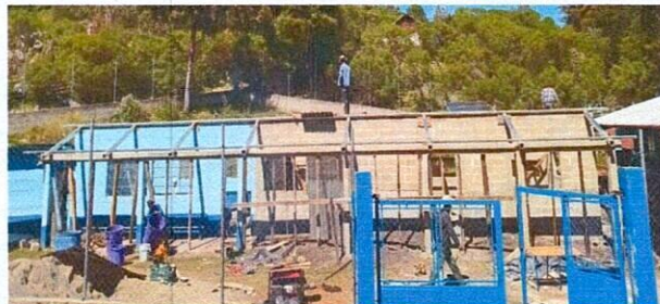
Foto 2. Se cambió la estructura del techo.
