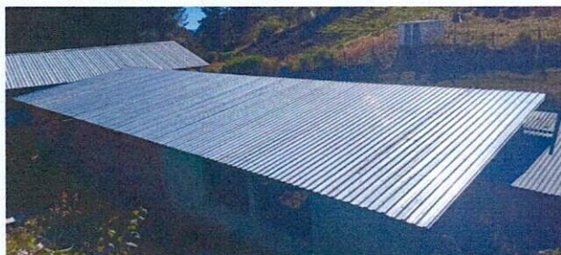
Foto 1. Se sustituyó el techo aulas y cocina
