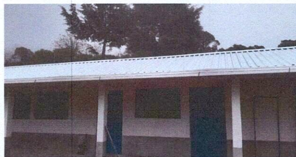
Foto 4. Se instalaron canales y bajadas de agua.
