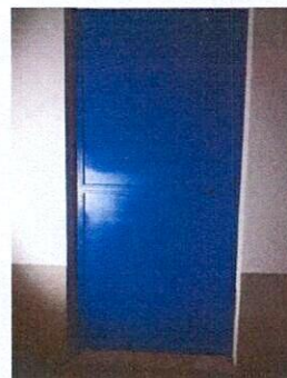
Foto 8. Se sustituyó puerta de metal en aula.
