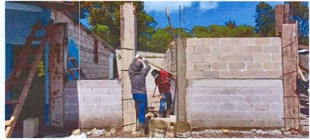
Foto 10: Se procedió a reparar muros de contención debido a daños causados por el clima.
