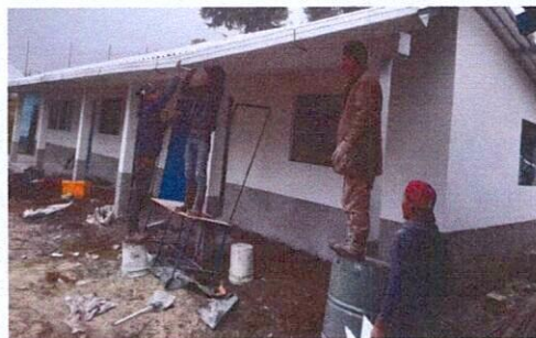
Foto 4. Se reemplazaron canales y bajadas de agua.
