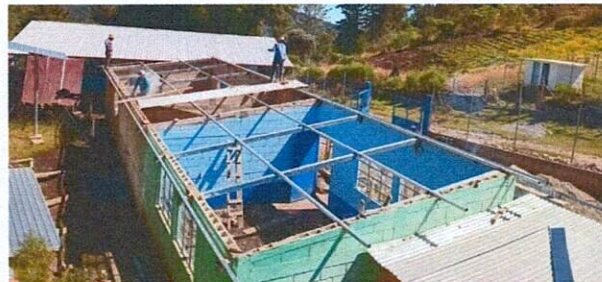
Foto 2. Quitaron las vigas de madera dañada por la humedad.
