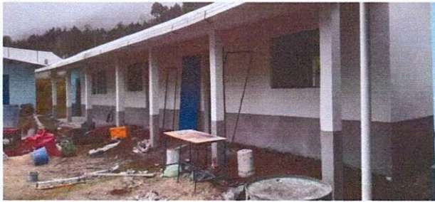
Foto 9: Quitaron puertas occidada en cocina para su posterior cambio.
