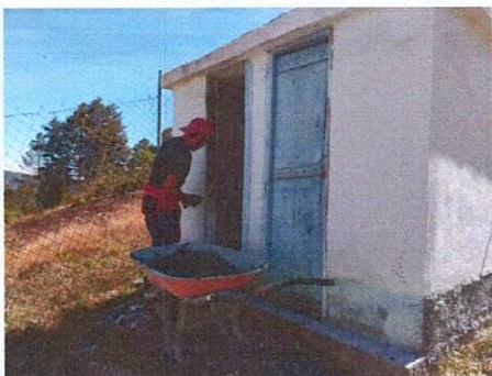
Foto 3. Se procedió a colocar marco y puertas en servicios sanitarios.
