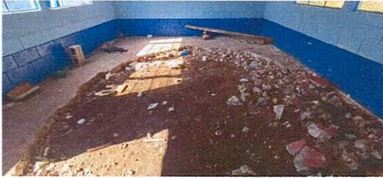
Foto 7: Se procedió a romper el piso dañado del aula para colocar el nuevo
