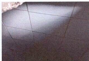
Foto 6. Procedieron a colocar azulejo para evitar la humedad.
