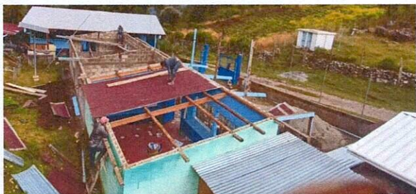
Foto 1. Se procedió a quitar la lámina vieja y agujerada de las clases.
