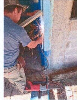
Foto 8: Se sustituyeron puertas de aula debido a su mal estado.
