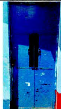
Foto 8: Es necesario sustituir las puertas de metal del aula.
