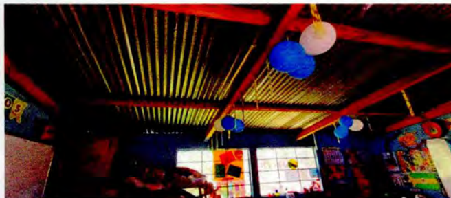
Foto 2: Es necesario sustituir estructura de madera por metal debido a que se encuentran en mal estado.
