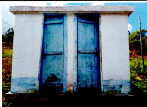
Foto 3: La sustitución de puertas de metal son necesarias en los servicios sanitarios.
