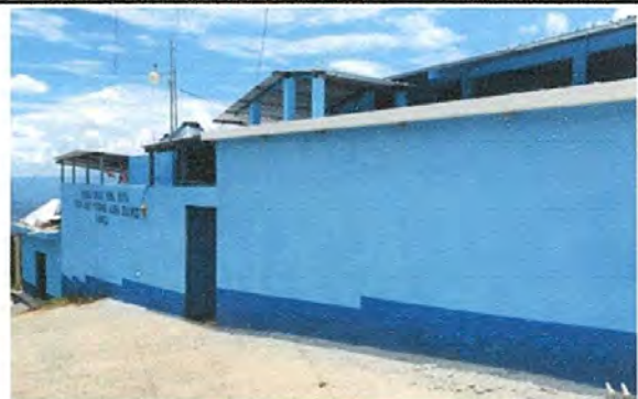
FOTO 12: REPELLO DE MURO Y DE AULA
