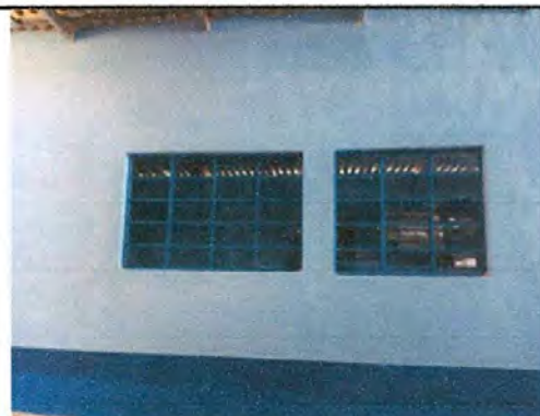
FOTO 4: SUSTITUCIÓN DE VENTANAS DE MADERA POR METAL
