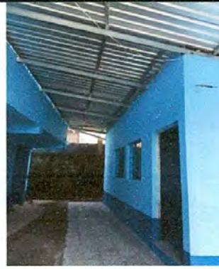
FOTO 1: SUSTITUCIÓN DE LÁMINA POR LÁMINA TROQUELADA ALUCIN CALIBRE 26 PARA AULA Y BAÑO
