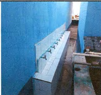
FOTO 9: REPARACION A SUSTITUCION DE AZULEJOS EN MINGITORIO Y LAVAMANOS
