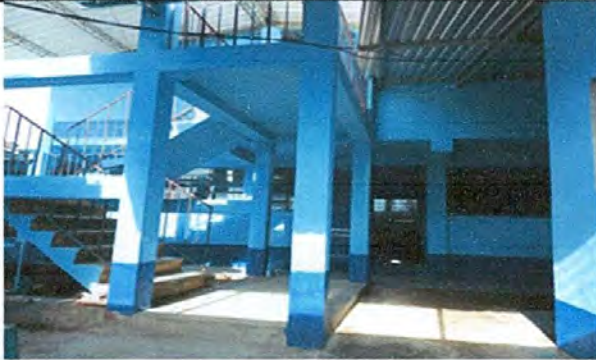
FOTO 7: PINTURA EN MUROS Y PAREDES EXTERNOS E INTERNOS
