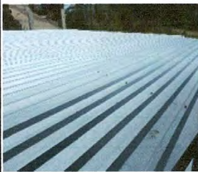
FOTO 1: SUSTITUCIÓN DE LÁMINA POR LÁMINA TROQUELADA ALUCIN CALIBRE 26 PARA AULA Y BAÑO
