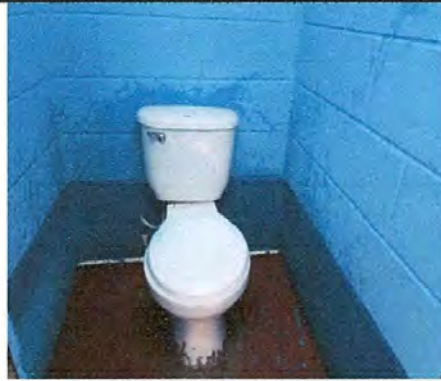
FOTO 8: SUSTITUCION DE INODOROS
