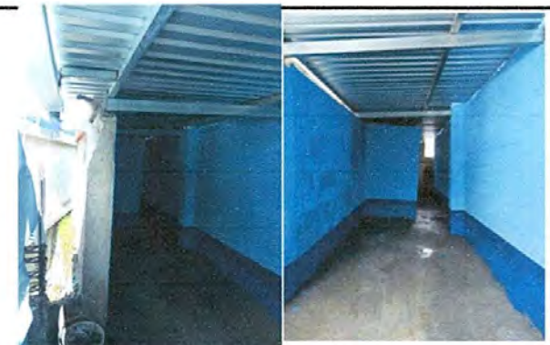
FOTO 10: SUSTITUCION DE TUBERIA PVC LINEAL PRINCIPAL AGUAS NEGRAS EN SANITARIOS
