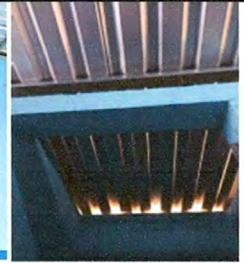
FOTO 1: SUSTITUCIÓN DE LÁMINA POR LÁMINA TROQUELADA ALUCIN CALIBRE 26 PARA AULA Y BAÑO
