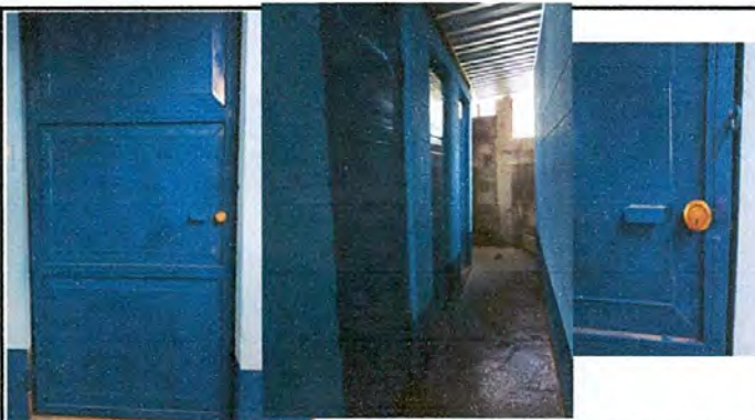
FOTO 3: MANTENIMIENTO ESTRUCTURA Y PINTURA DE PUERTAS DE AULA, PORTON Y PUERTAS DE BAÑO
