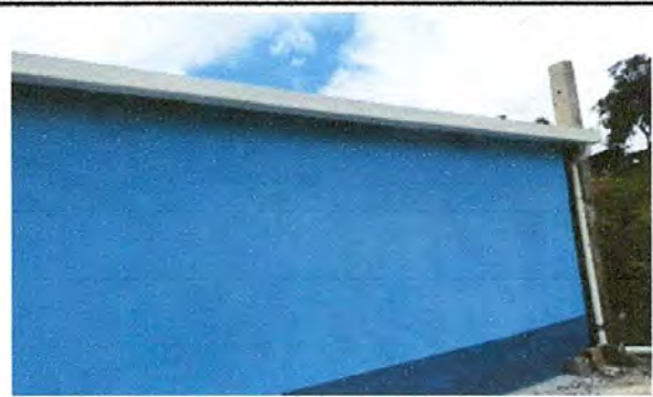
FOTO 6: SUSTITUCIÓN DE CANAL DE METAL DE AULA
