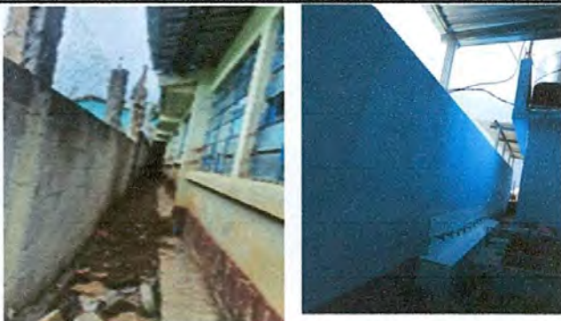
FOTO 11: REPARACION DE MURO PERIMETRAL
