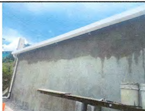
FOTO 6: SUSTITUCION DE CANAL DE METAL DE AULA
