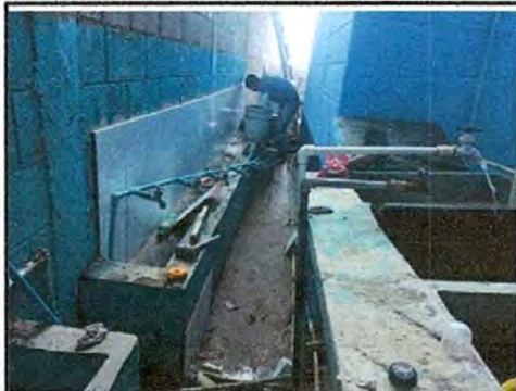
FOTO 9: REPARACION A SUSTITUCION DE AZULEJOS EN MINGITORIO Y LAVAMANOS
