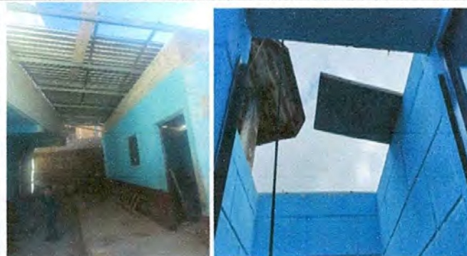
FOTO 1: SUSTITUCIÓN DE LÁMINA POR LÁMINA TROQUELADA ALUCIN CALIBRE 26 PARA AULA Y BAÑO
