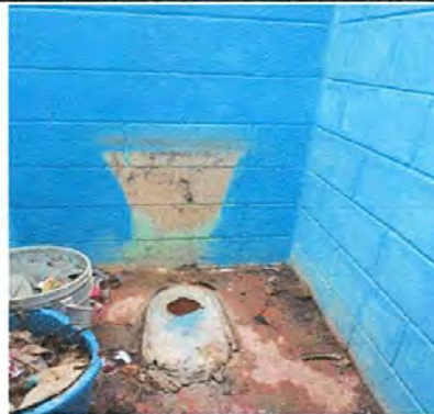
FOTO 8: SUSTITUCION DE INODOROS
