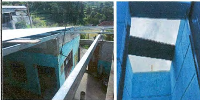
FOTO 1: SUSTITUCIÓN DE LÁMINA POR LÁMINA TROQUELADA ALUCIN CALIBRE 26 PARA AULA Y BAÑO
