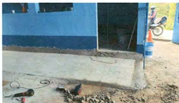
FOTO 5: REPARACION DE PISO EN AULAS, PATIO Y CORREDOR
