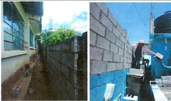
FOTO 11: REPARACION DE MURO PERIMETRAL
