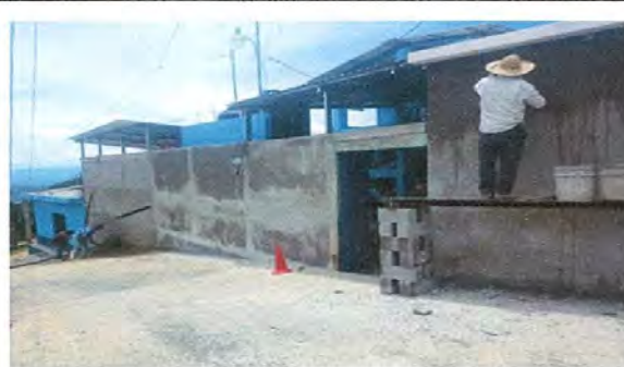
FOTO 12: REPELLO DE MURO Y DE AULA
