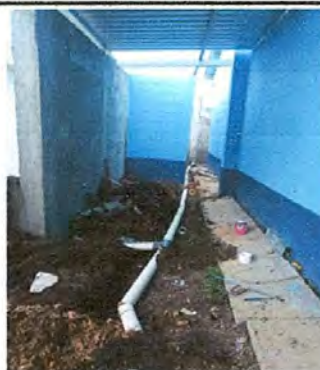
FOTO 10: SUSTITUCION DE TUBERIA PVC LINEAL PRINCIPAL AGUAS NEGRAS EN SANITARIOS
