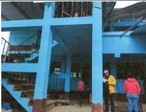
FOTO 7: PINTURA EN MUROS Y PAREDES EXTERNOS E INTERNOS
