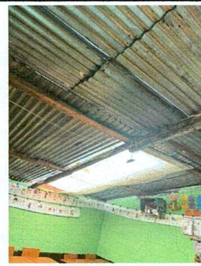
Foto 4: REPARACIÓN SISTEMA ELECTRICO
