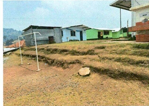
Foto 6: LOSA DE PATIO
