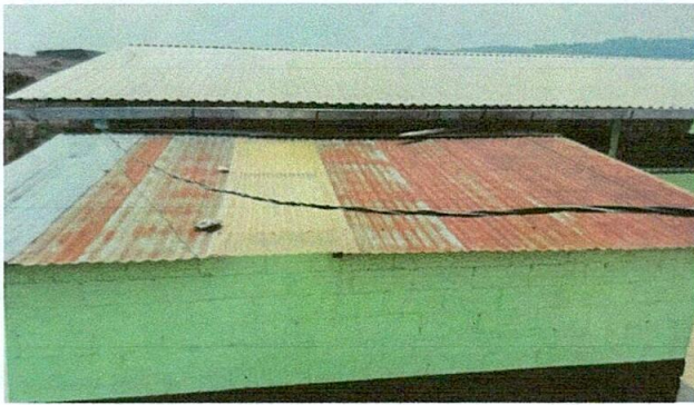
Foto 1: CUBIERTA DE LÁMINA
