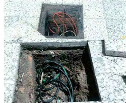
Foto 6: Reparación de cableado eléctrico
