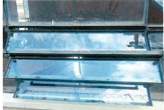
Foto 2: sustitución de vidrios.
