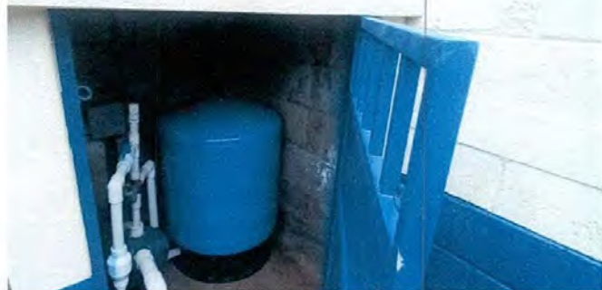
Foto 7: Reparación de bomba de agua más accesorios
