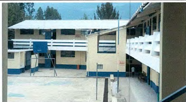
Foto 11: Vista interna de un costado
