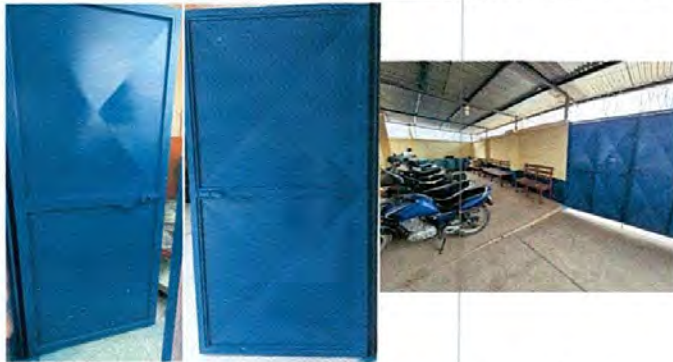
Foto1: Mantenimiento a estructura de puertas de metal (lijado y aplicación de pintura de aceite).
