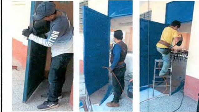
Foto1: Mantenimiento a estructura de puertas de metal (lijado y aplicación de pintura de aceite).
