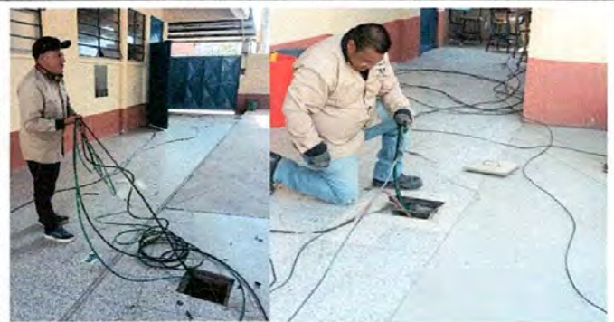
Foto 6: Reparación de cableado eléctrico
