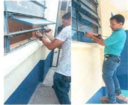
Foto 2: sustitución de vidrios.
