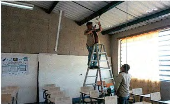
Foto 5: Sustitución bases de lámpara fluorescentes a plafoneras y sustitución de lámparas fluorescentes a bombillas led.
