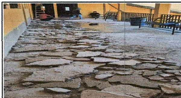
Foto 3: Colocación de piso
