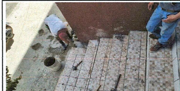
Foto 6: colocación de pisos
