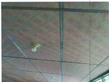
Foto 7: SUSTITUCIÓN DE ELEMENTOS DE FIJACIÓN, CAMBIO DE CIELO FALSO
