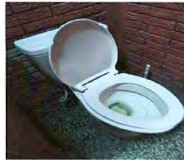
Foto 12: SUSTITUCIÓN DE INODORO
