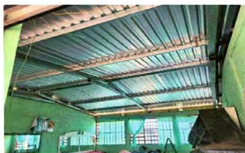
Foto 2: SUSTITUCIÓN DE TECHO TIPO TEJA POR LAMINA TROQUELADA
