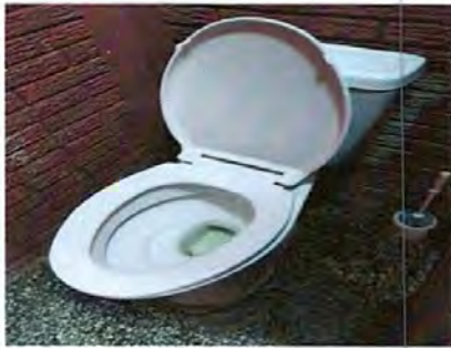
Foto 11: SUSTITUCIÓN DE INODORO
