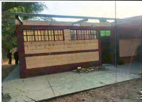
Foto 1 SUSTITUCIÓN DE TECHO TIPO TEJA POR LAMINA TROQUELADA
