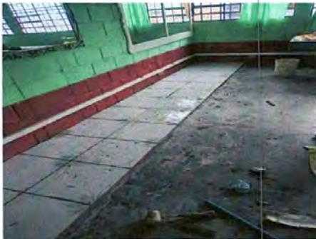
Foto 9: SUSTITUCIÓN DE ELEMENTOS DE FIJACIÓN CAMBIO DE PISO
