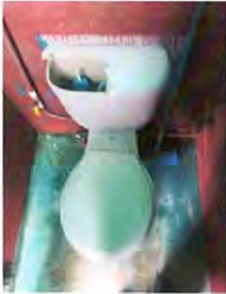
Foto 11: SUSTITUCIÓN DE INODORO
