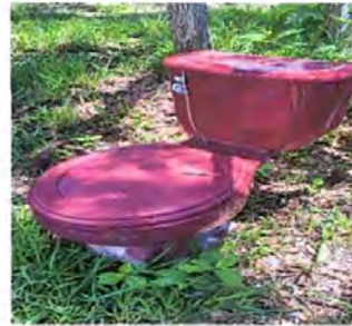
Foto 12: SUSTITUCIÓN DE INODORO
