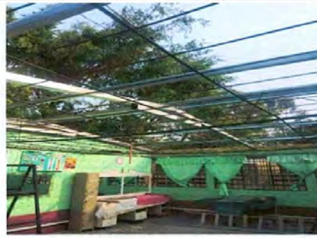
Foto 6: SUSTITUCIÓN DE ELEMENTOS DE FIJACIÓN, CAMBIO DE CIELO FALSO
