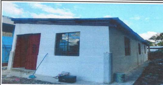
Foto1: Mejoramiento de Paredes.
