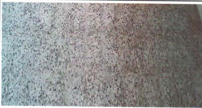
Foto 9: Sustitución de torta de cemento, por piso granito.
