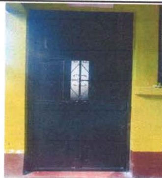
Foto 4: Sustitucion de puertas
