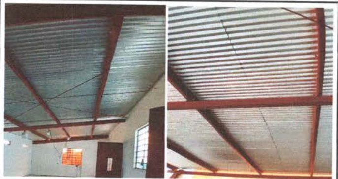
Foto 3: Mantenimiento de estructura de soporte de metal
