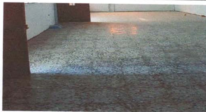
Foto 2: Sustitución de torta de cemento, por piso granito.
