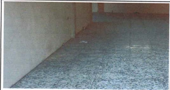
Foto 8: Sustitución de torta de cemento, por piso granito.
