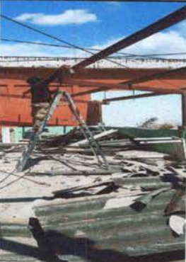
Foto 3: Mantenimiento de estructura de soporte de metal
