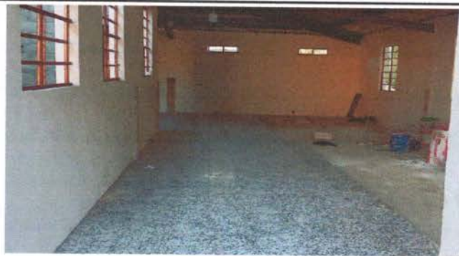
Foto 8: Sustitución de torta de cemento, por piso granito.
