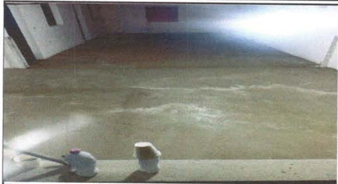
Foto 7: Sustitución de torta de cemento, por piso granito.
