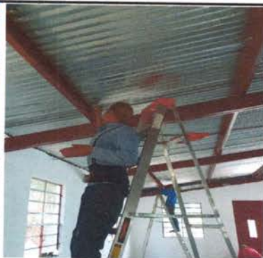
Foto 3: Mantenimiento de estructura de soporte de metal
