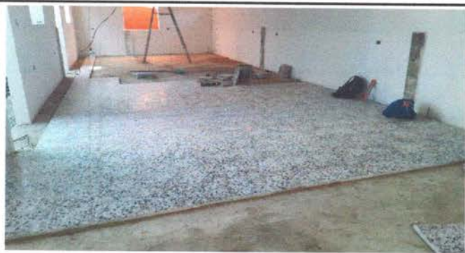
Foto 9: Sustitución de torta de cemento, por piso granito.
