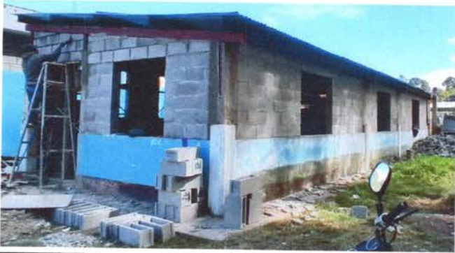
Foto1: Mejoramiento de Paredes.
