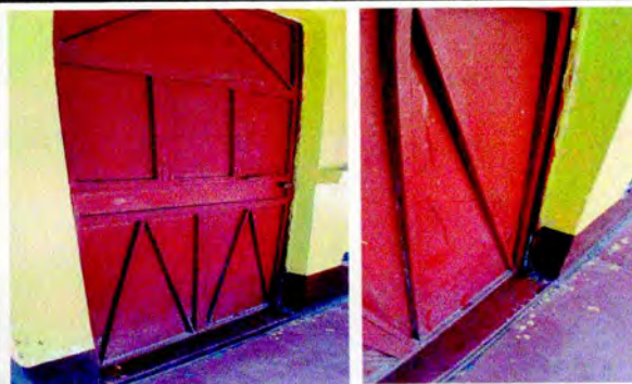
Foto 4: Sustitución de puertas
