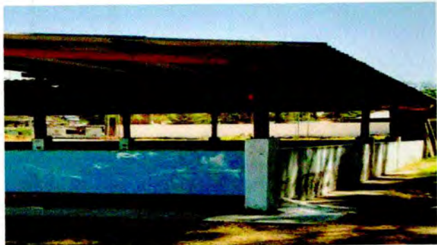
Foto 1: Mejoramiento de Paredes.
