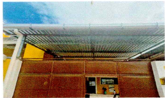
Foto 4: canales y bajadas de agua pluvial
