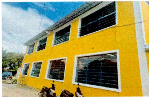
Foto 3: Sustitución de vidrios
