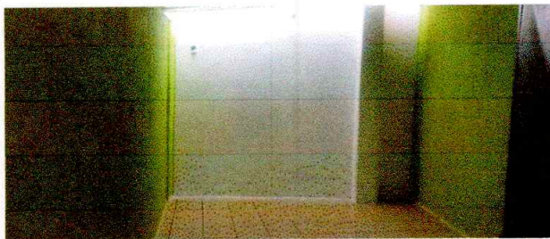
Foto 5: pintura de muros interiores
