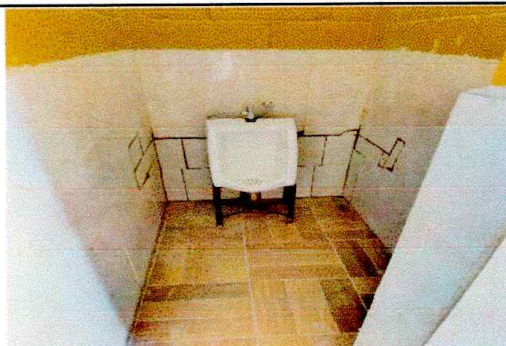
Foto 6: Sustitución de mingitorios
