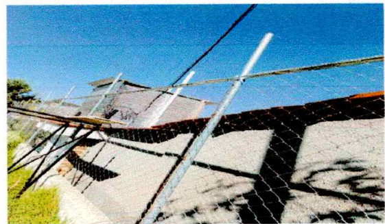
Foto 6: mejoramiento de cerco o muro perimetral
