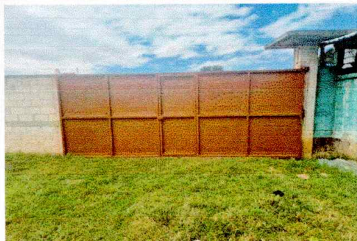
Foto 2: Mantenimiento a portón de metal
