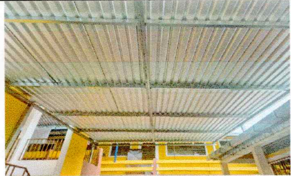
Foto 2: Sustitución de Estructura de techo costanera galvanizada
