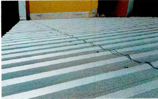
Foto1: sustitución de lamina troquelada
