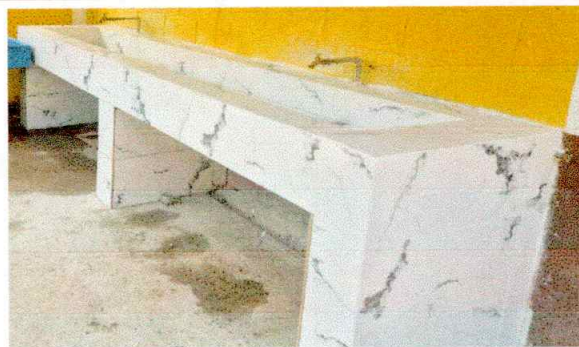
Foto 4: mejoramiento de azulejo
